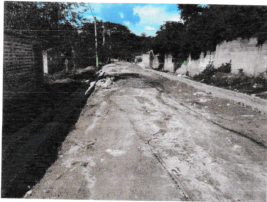
Construcción de cordón cuneta en estacionamiento 0+055 en ambos costados.
