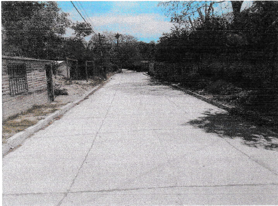
Pavimento hidráulico terminado en estacionamiento 0+065 en ambos costados de calle.
