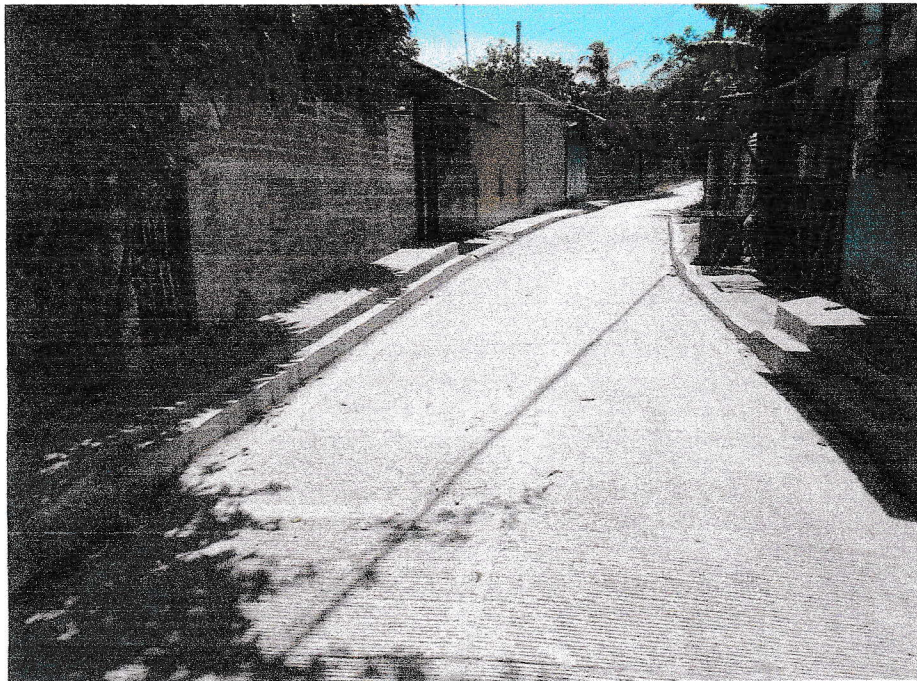
Pavimento hidráulico terminado en estacionamiento 0+165 en ambos costados de calle.
