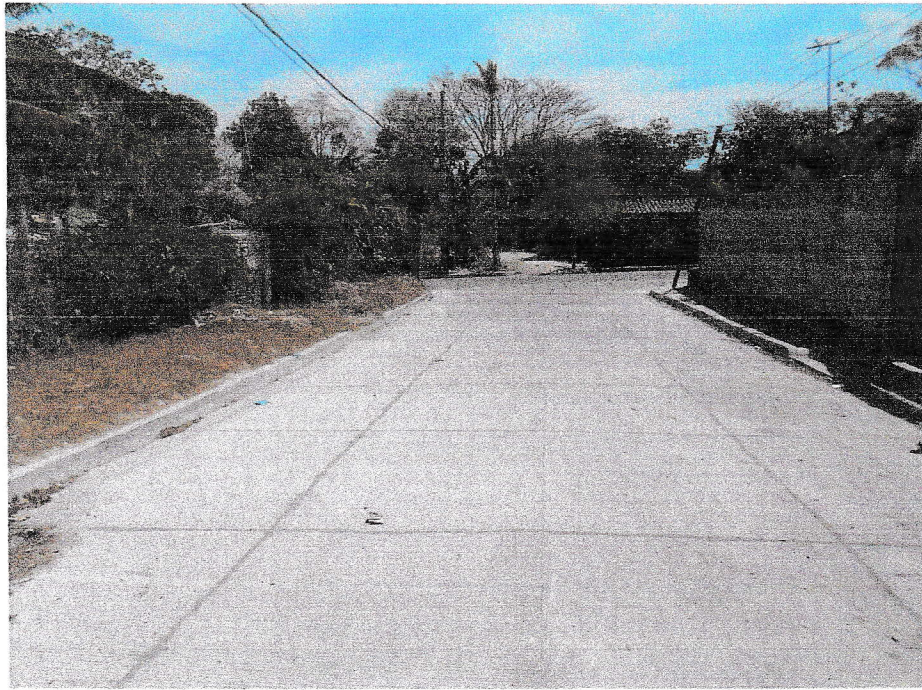
Pavimento hidráulico terminado en estacionamiento 0+045 en ambos costados de calle.
