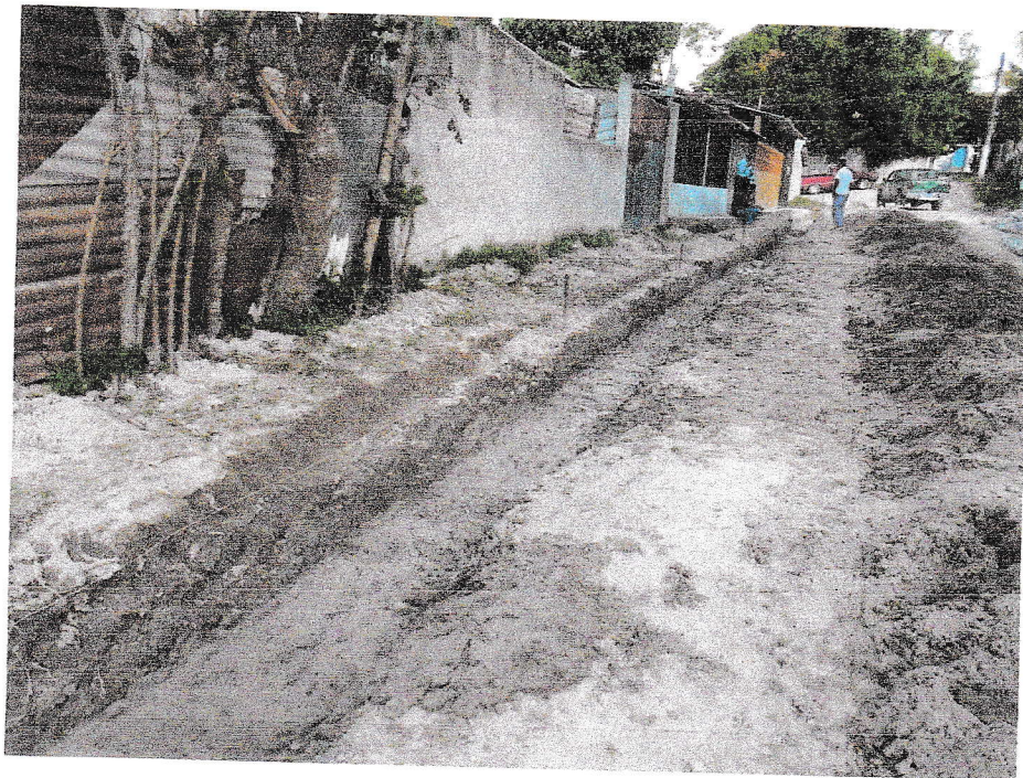
Estabilización suelo para cordón cuneta en estacionamiento 0+142 en el costado Oriente.
