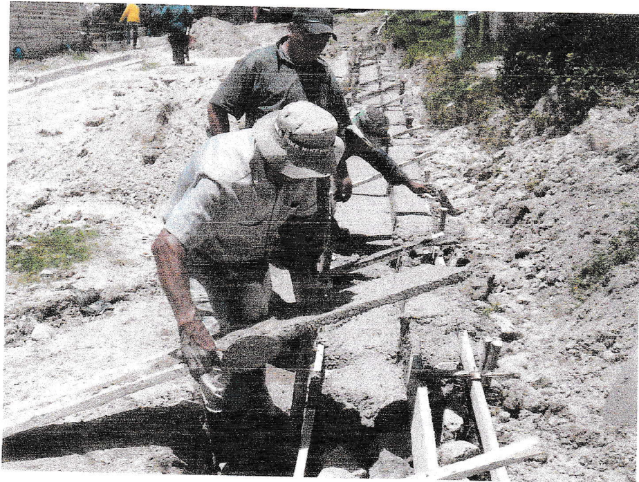
Fraguado de cordón cuneta en estacionamiento 0+075 en el costado Sur.
