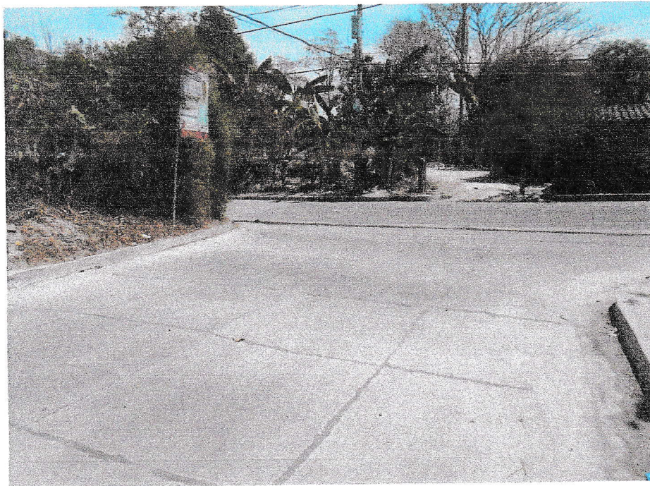
Pavimento hidráulico terminado en estacionamiento 0+025 en ambos costados de calle.
