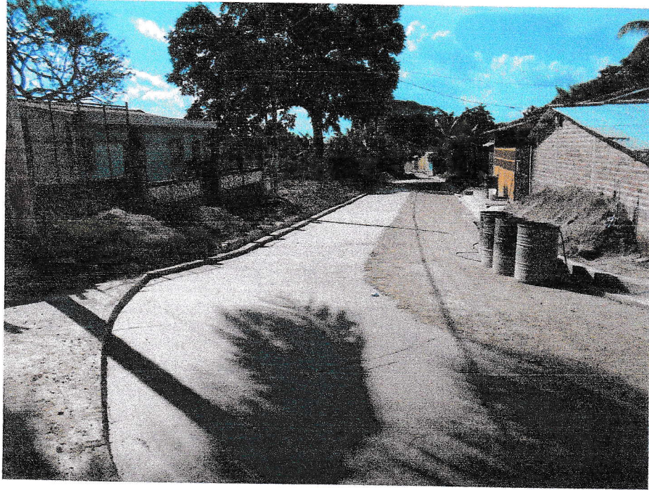
Construcción base de lodocreto en estacionamiento 0+090 en ambos costados de calle.
