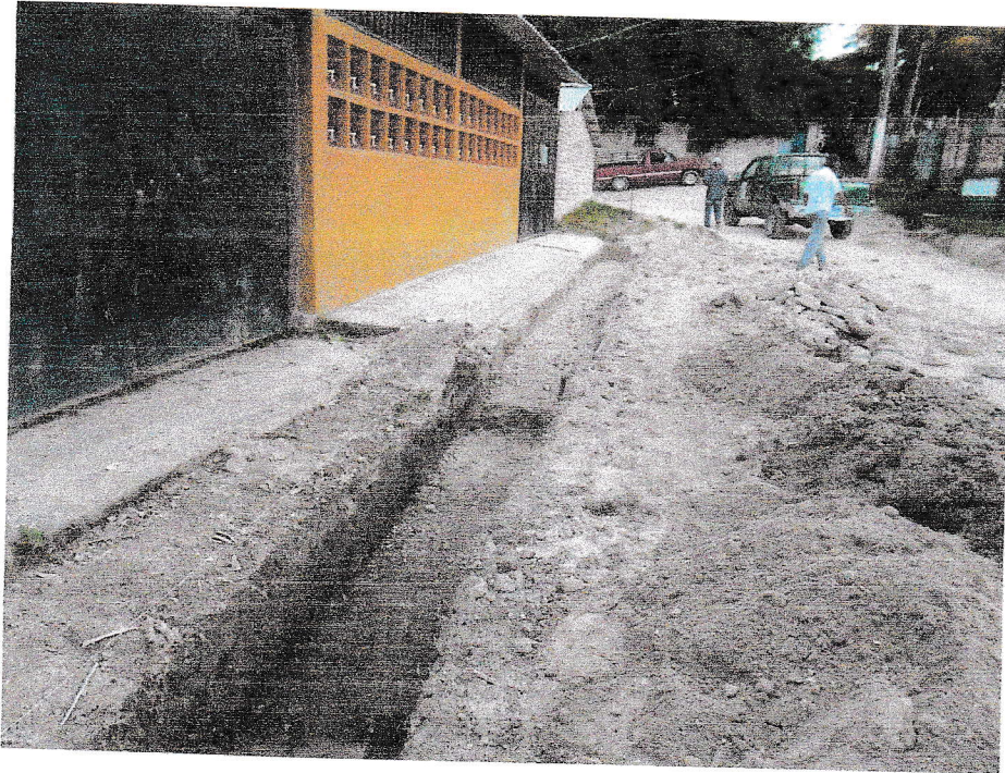
Excavación para cordón cuneta en estacionamiento 0+109 en el costado Oriente.
