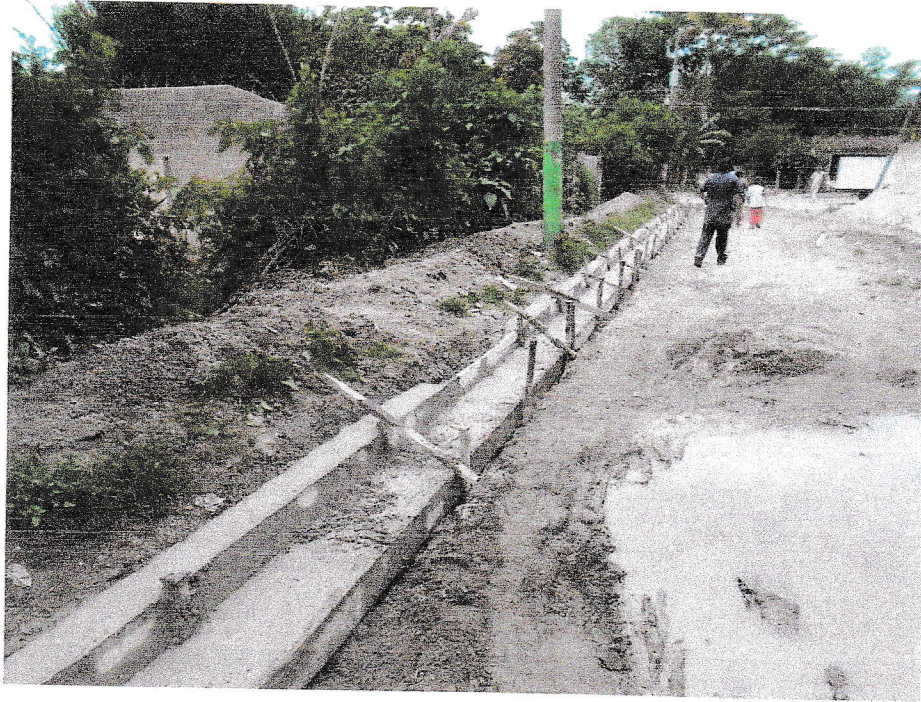
Construcción de cordón cuneta en estacionamiento 0+035 en el costado Norte.
