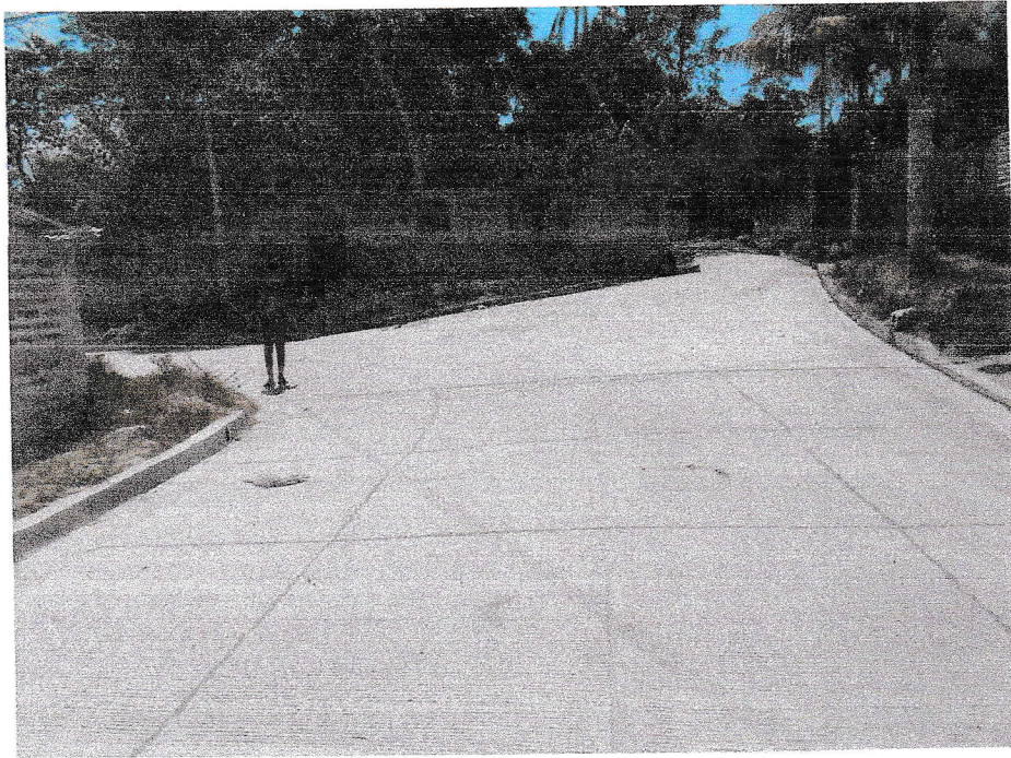
Pavimento hidráulico terminado en estacionamiento 0+082 en ambos costados de calle.
