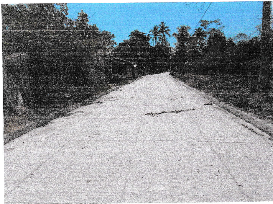
Pavimento hidráulico terminado en estacionamiento 0+102 en ambos costados de calle.
