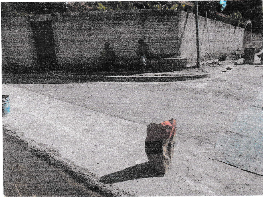
Construcción de pavimento hidráulico en estacionamiento 0+010 en el costado Sur.
