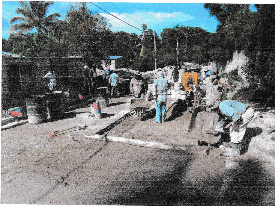
Construcción base de lodocreto en estacionamiento 0+063 en el costado Sur.
