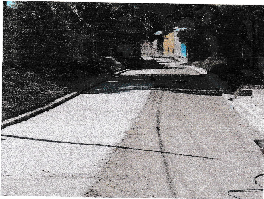
Construcción base de lodocreto en estacionamiento 0+130 en ambos costados de calle.
