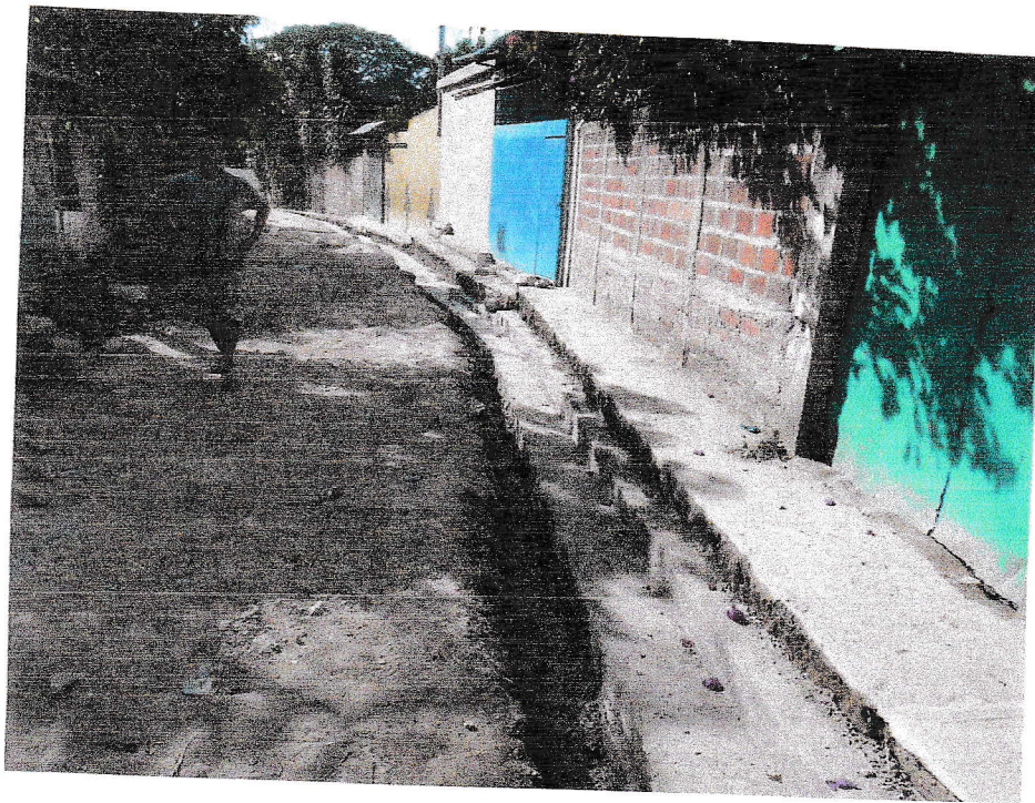
Construcción de cordón cuneta en estacionamiento 0+165 en el costado Poniente.
