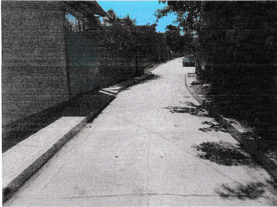
Pavimento hidráulico terminado en estacionamiento 0+135 en ambos costados de calle.
