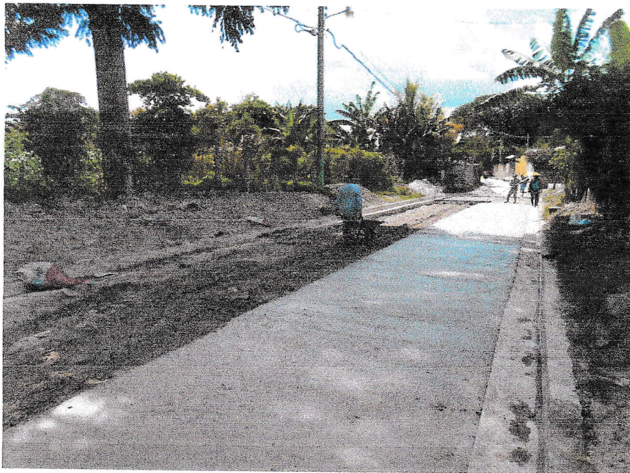
Construcción base de lodocreto en estacionamiento 0+105 en el costado Oriente.
