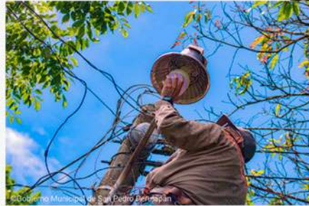
Mantenimiento de alumbrado publico.
