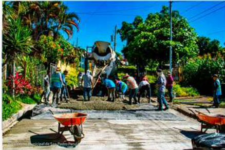
Pavimentacion calle de sector Loma Linda, Cantón La Loma
