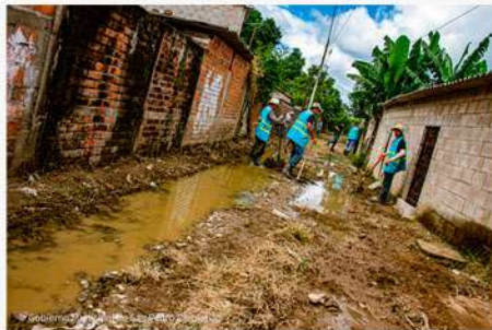
Inicio de proyecto de pavimentación en calle al estadio en istagua
