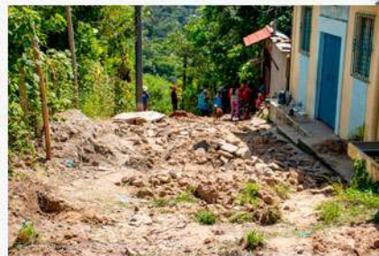
Inicio de Pavimentacion en calle de Caserio El Cerro, Cantón El Espino
