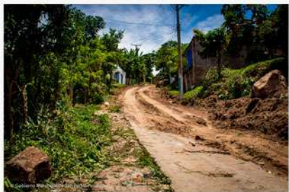
Inicio de Pavimentacion en calle del Cantón El Paraiso
