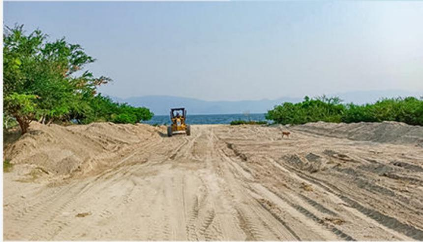
La maquinaria de nuestra municipalidad realizó 450 metros lineales de conformación de borda en canton San Agustín, con el objeto de canalizar adecuadamente el caudal de aguas lluvias provenientes del arenal.
