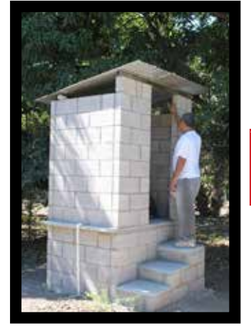
Construcción de letrinas tipo abonera en 6 comunidades del Municipio.
