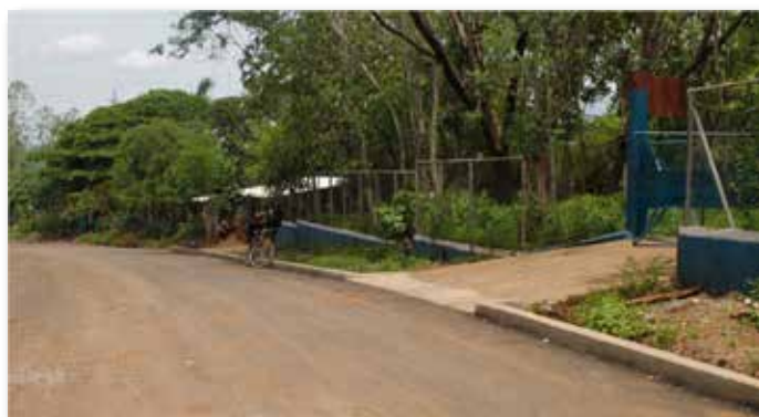
Pavimentación de calle tramo El Guajoyo.
