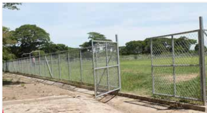
Construcción de cancha de fútbol en comunidad La Sabana.
