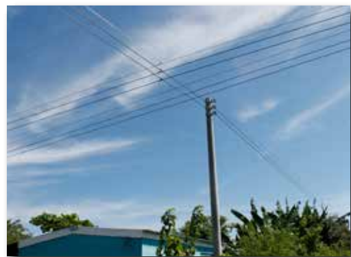
Ampliación de energía eléctrica en comunidad Santa Teresa II.
