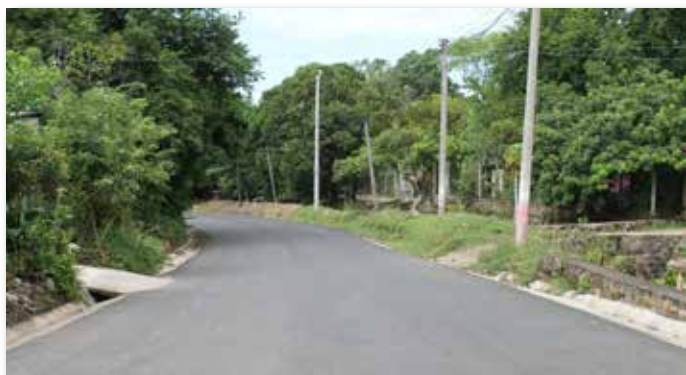
Pavimentación de calle El Carao a Las Pampitas.
