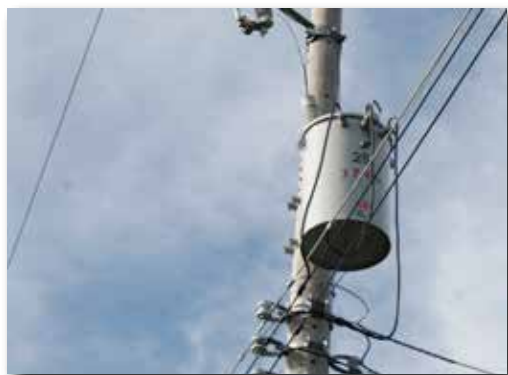
Introducción de energía eléctrica en comunidad Buena Vista.
