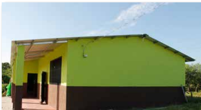
Construcción de casa comunal Puente de Oro.
