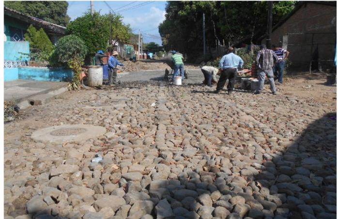
Parte del proyecto: Balastado, conformado, cunetas y compactación de superficie de rodamiento en calles de acceso de Colonia Cruz N° 1, 2 y Col. Aledañas
