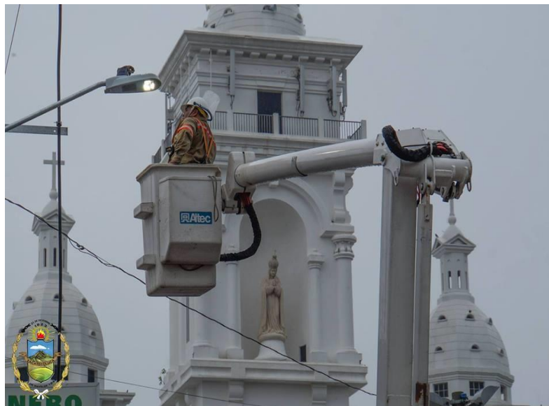
PROYECTO SUSTITUCION DE 1,775 LAMPARAS LED EN ZACATECOLUCA
