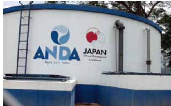
Proyecto de agua potable en Sesori, San Miguel
