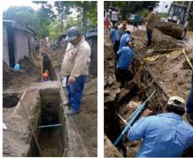
Elaboración de zanja e Instalación de tubería
