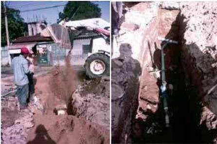
Compactado de tubería e instalación de tubería en zanja
