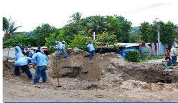
ANDA REPARA LÍNEA DE IMPELENCIA QUE AFECTÓ SERVICIO EN ILOPANGO
