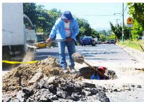
REPARAN TUBERÍA QUE AFECTABA SUMINISTRO EN PRADOS DE VENEZIA III
