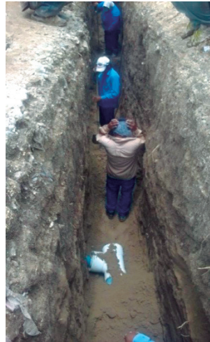
Instalación de tubería
