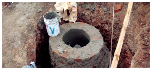
Construcción de pozo de aguas negras
