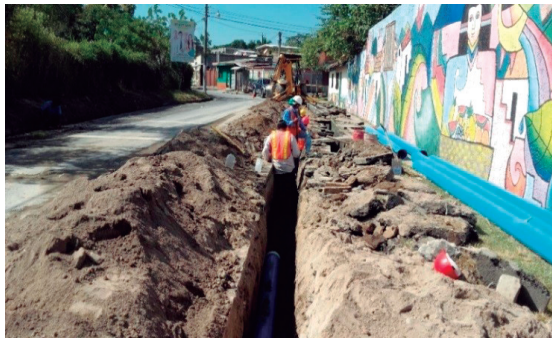
Proceso de instalación de tubería
