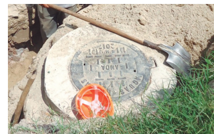
Introducción del sistema de alcantarillado sanitario tipo simplificado-condominial e introducción del sistema de distribución de agua potable a la comunidad Santa Gertrudis, en San Martín.
