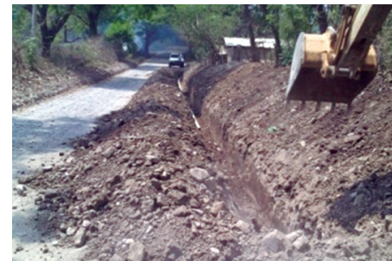
Trabajos de excavación para instalación de tubería
