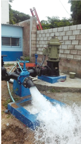
Pruebas de funcionamiento de equipo de bombeo
