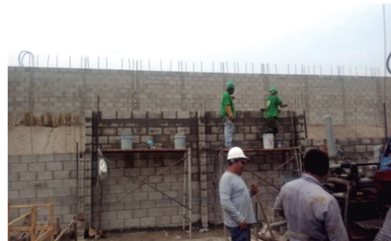
Construcción de tapial en predio de pozo
