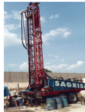
Perforación de Pozo N° 1 Los Llanitos.
