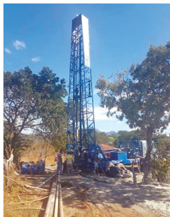
Perforación del pozo 1 de Boquín
