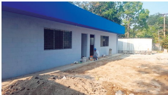
Obras complementarias, fachada del Centro de Formación Integral.
