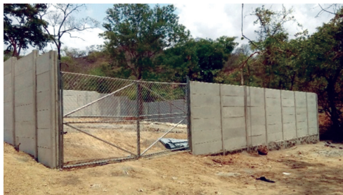
Muro perimetral y portón de acceso
