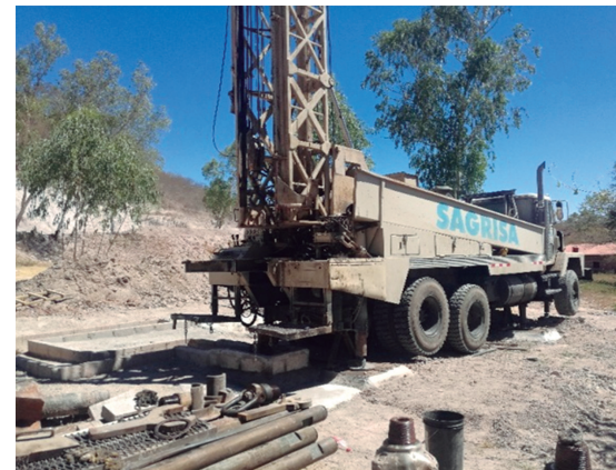
Revestimiento de pozo Anamorós.
