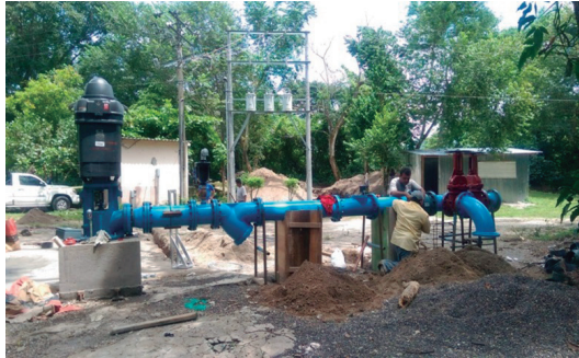
Perforación de pozo No. 6 producción Guluchapa, Ilopango, San Salvador.
