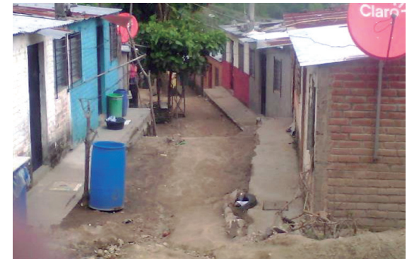
Pasajes de la comunidad Bonanza donde ya se instaló tubería de distribución.
