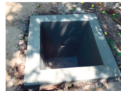
Introducción del sistema de agua potable y saneamiento básico de diferentes caseríos en San Luis Talpa, de La Paz
