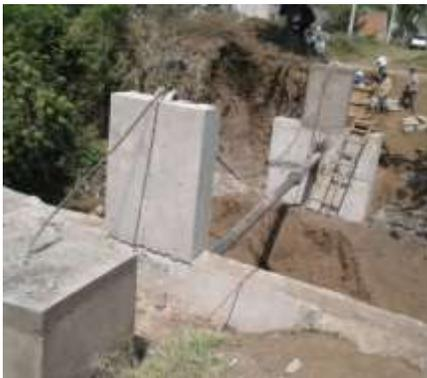
Construcción de paso aéreo para tubería de 8 pulgadas.
