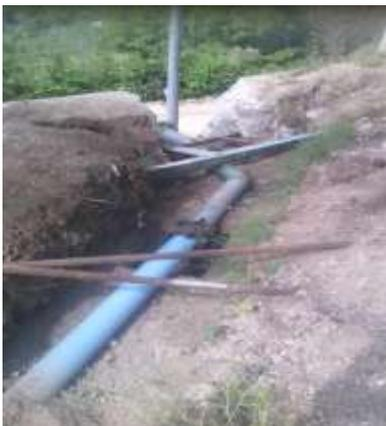
Empalme de tubería PVC a tubería de hierro galvanizado, en proyecto de San Jose Primero
