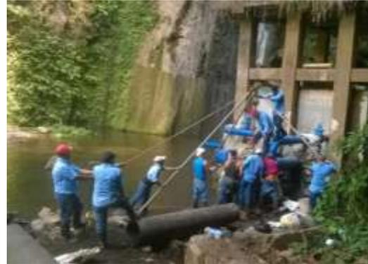
Trabajos de instalación de tubería de 14 y 16 pulgadas de diámetro en captación Talcomunca.
