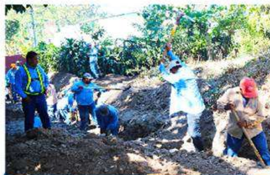
ANDA BENEFICIA A COMUNIDAD MONTALVO CON ALCANTARILLADO SANITARIO
