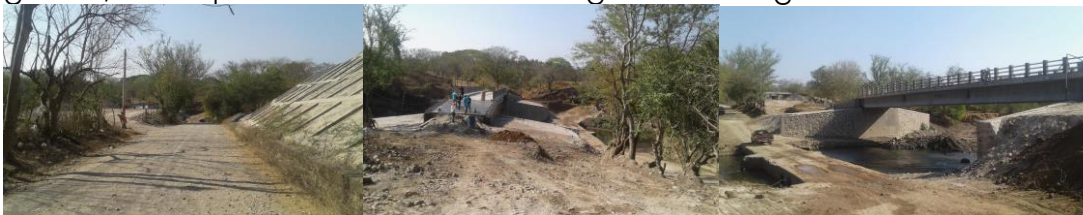
Imagen No. 1 Camino hacia Atiocoyo, antes de llegar al puente en construcción, a la izquierda
