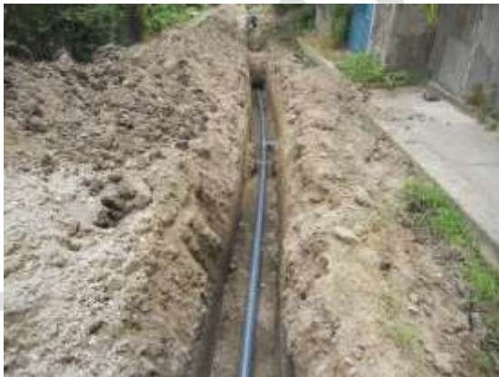
Instalación de tubería
