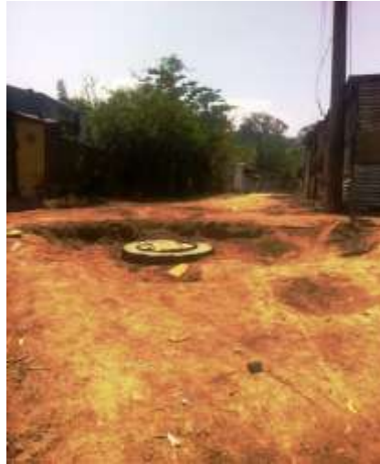
Elaboración de pozo de visita
