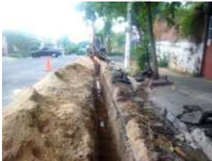
Instalación de Tubería
