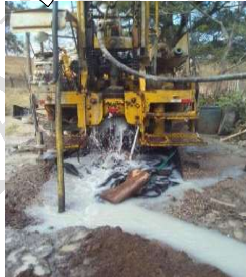
Proceso de perforación de pozo
