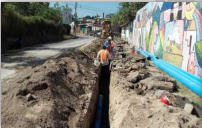
Instalación de tubería
