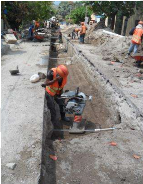
Aterrado y compactado
