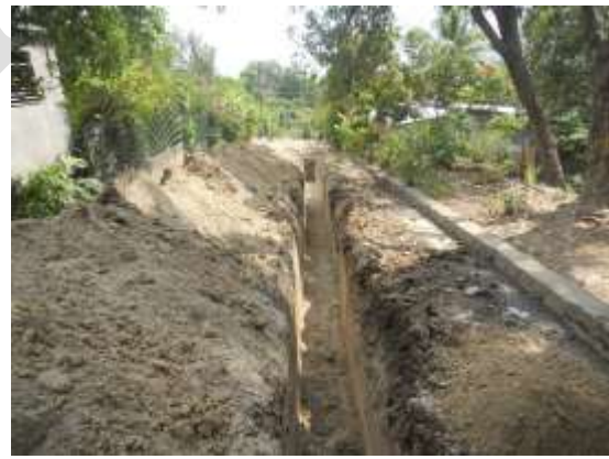
Elaboración de zanja
