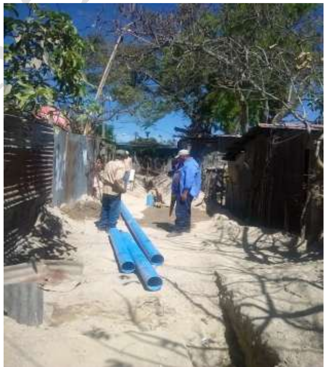
Instalación de Tubería
