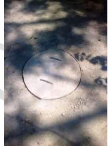
Pozo de visita terminado
