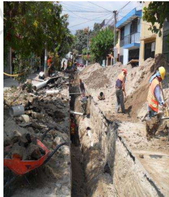
Instalación de tubería
