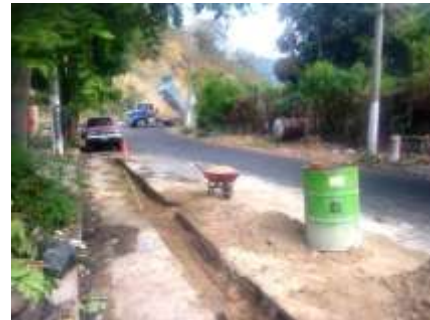
Aterrado y compactado
