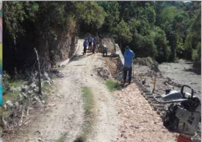
Proceso de compactado de muro
