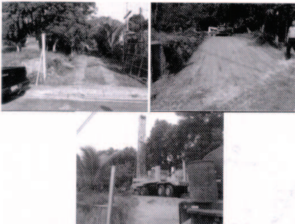
Figura 1: Máquina perforadora en el sitio y obras de terracería.
