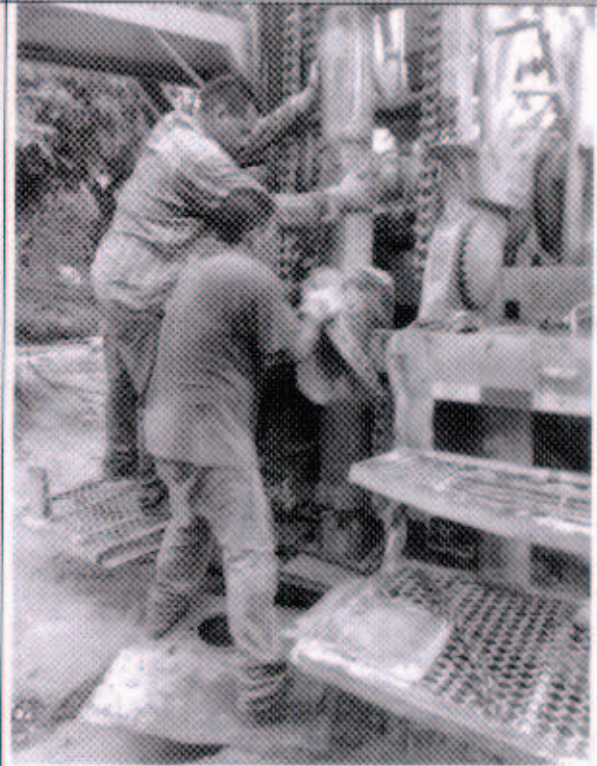
Perforación de Pozo en 17 ½"
