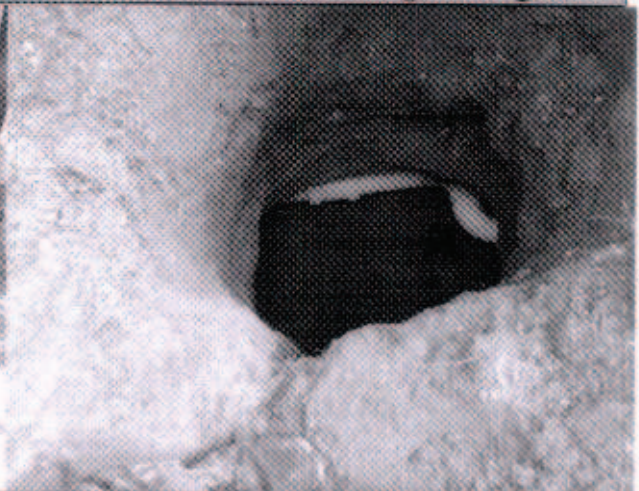
Instalación Tubería de 20"
