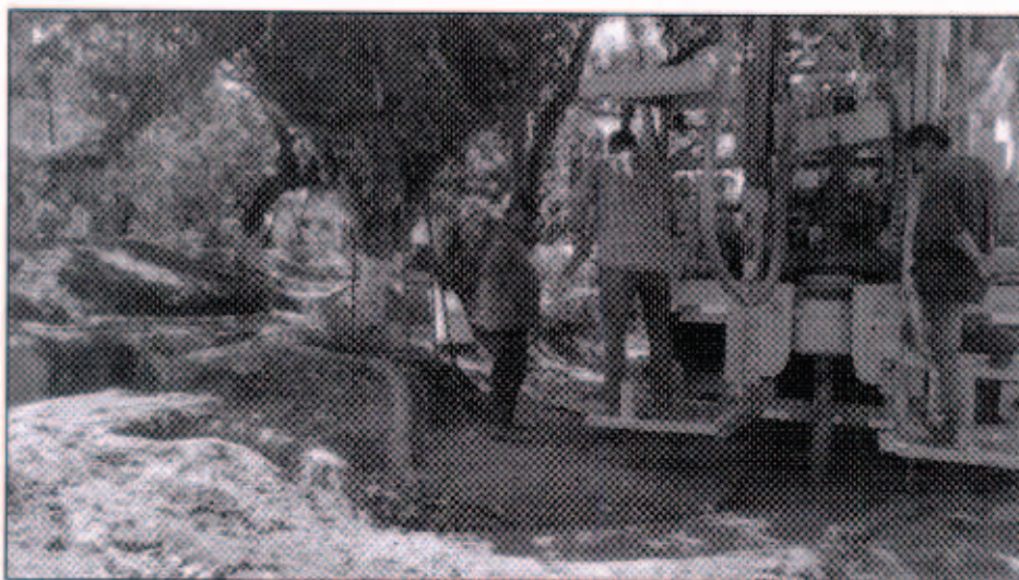
Figura 1: Perforación de pozo en diámetro de 17 ½ pulgadas.
