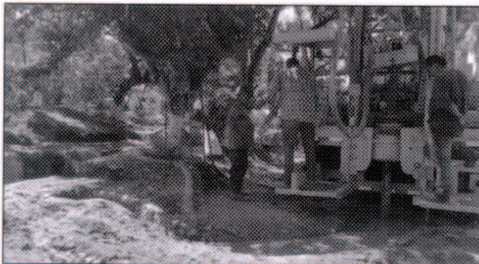
Figura 2: Perforación de antepozo.
