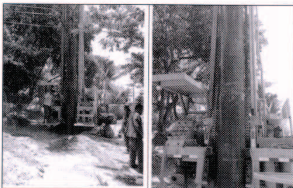
Figura 3: Instalación de tubería para antepozo.
