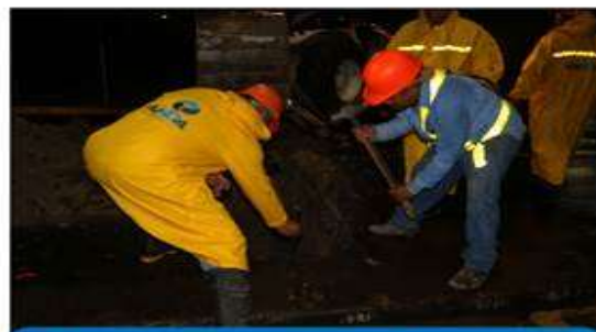
Brigada de ANDA repara colector de aguas negras, en la 1a. calle Poniente de San Salvador
