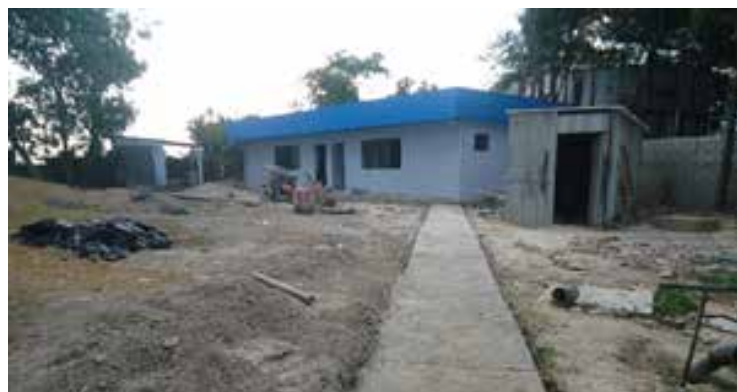
Construcción de dormitorios, acera y servicios sanitarios
