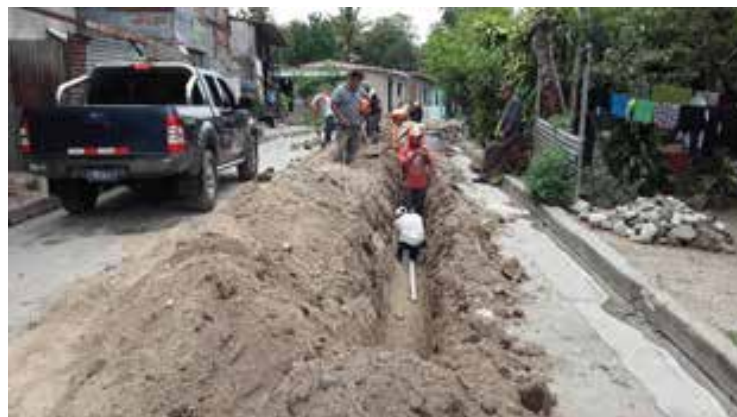
Instalación de tubería
