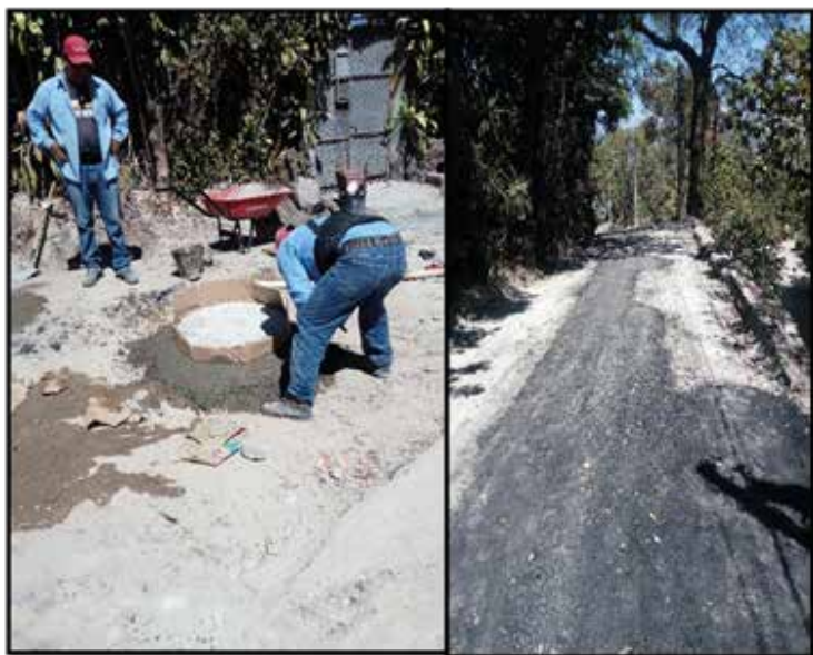
Construcción de pozo de aguas negras / Aterrado, compactado y pavimentado finalizado
