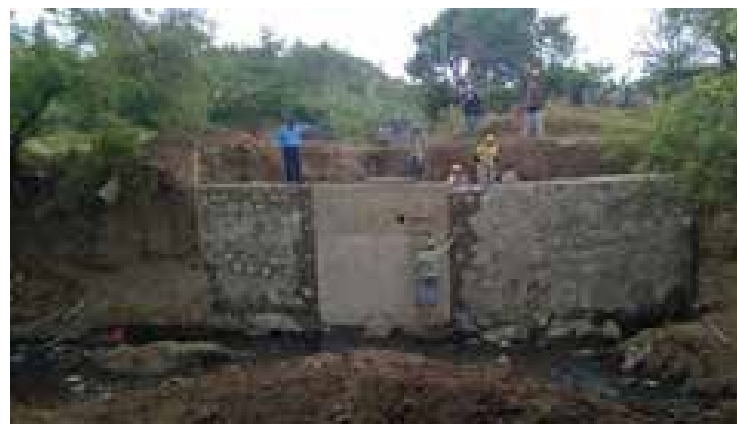
construcción de muro de retención y paso aéreo del colector
