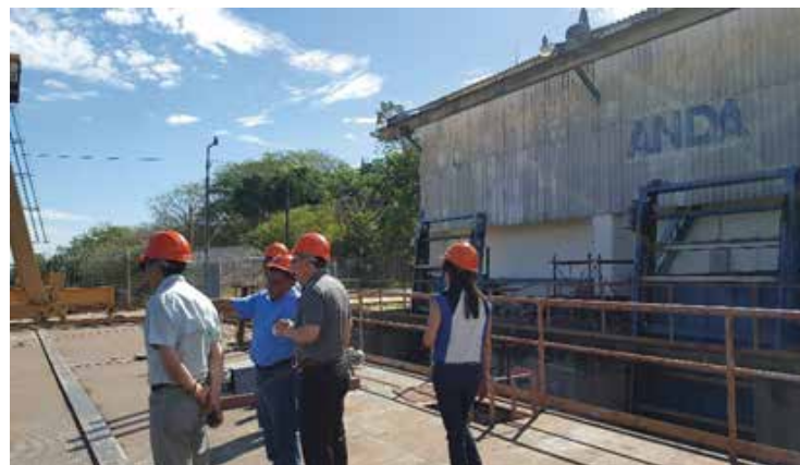
Planta Potabilizadora Las Pavas, departamento de La Libertad.
