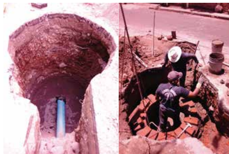
Elaboración de descarga / Elaboración de pozo de visita
