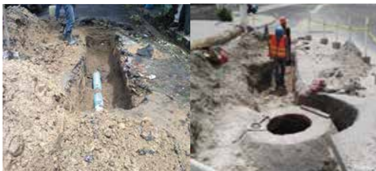
Instalación de tubería en colonia La Rábida, San Salvador
