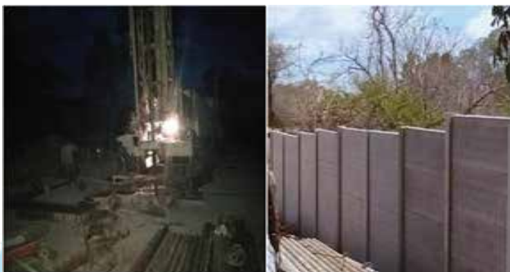
Perforación de pozo / Muro perimetral
