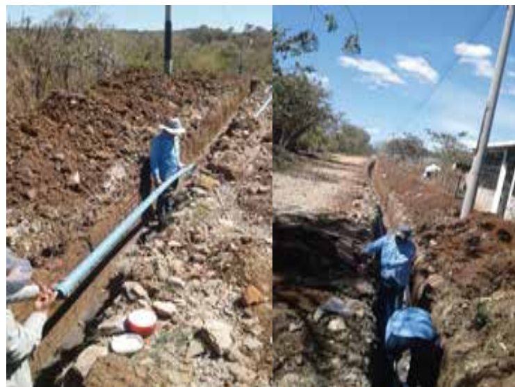
Instalación de tubería
