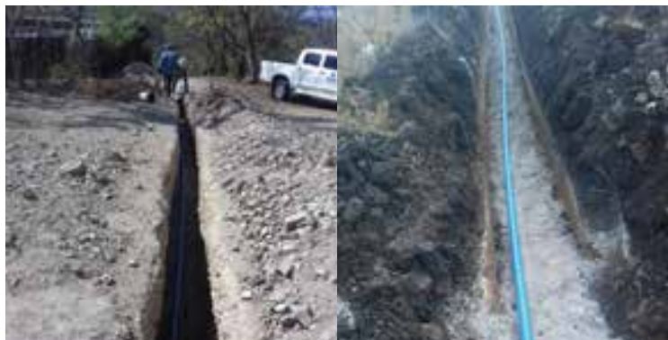
Zanjeo e instalación de tubería de red
