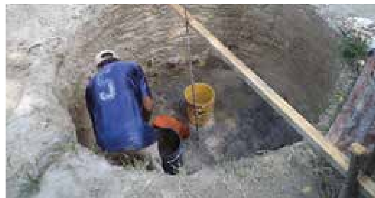
Excavación para construcción de pozo
