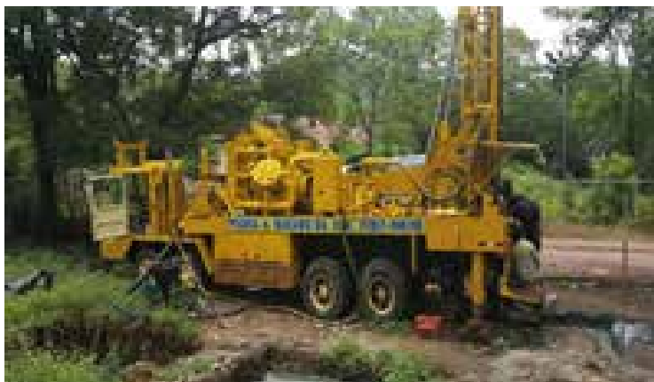
Perforación del pozo
