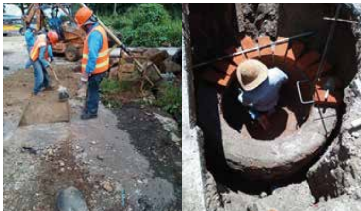
Aterrado y compactado / Instalación de tubería
