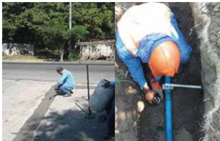
Aterrado y compactado / Instalación de tubería
