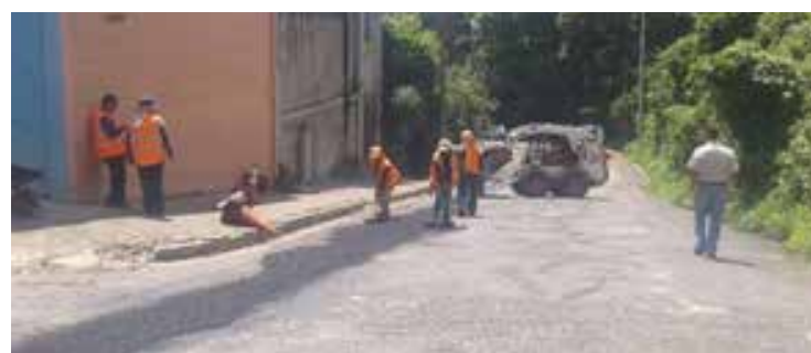
Aterrado, compactado y pavimentado
