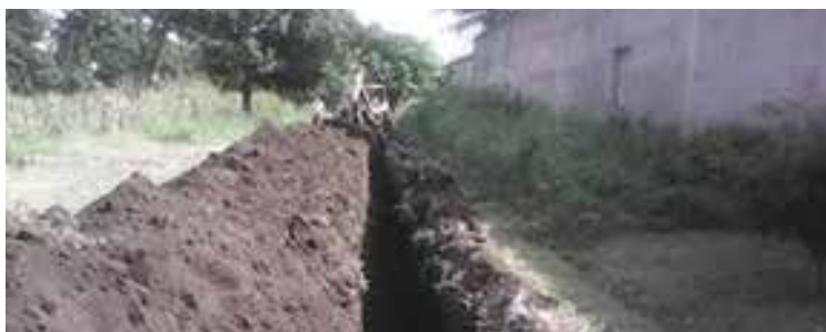
Excavaciones para instalación de tubería
