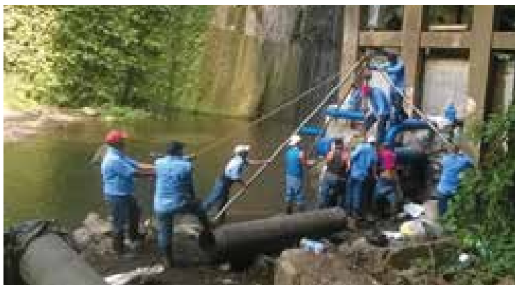
Colocación de manifold de descarga (árbol de descarga) de caja colectora.
