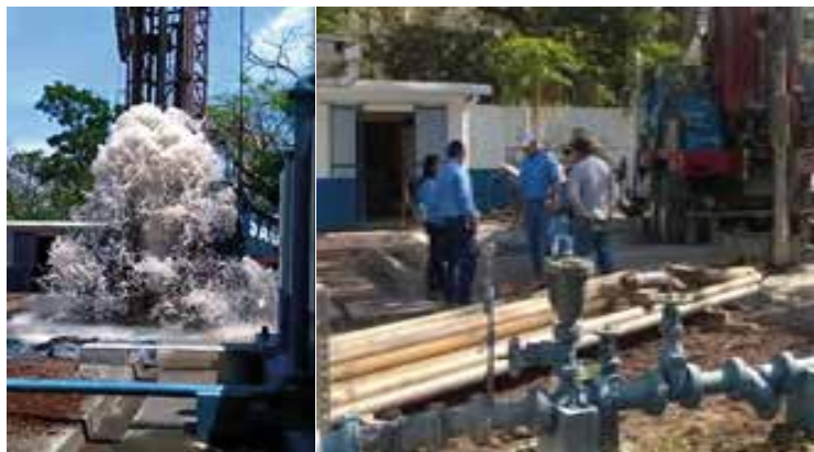
Limpieza de pozo / Perforación de pozo
