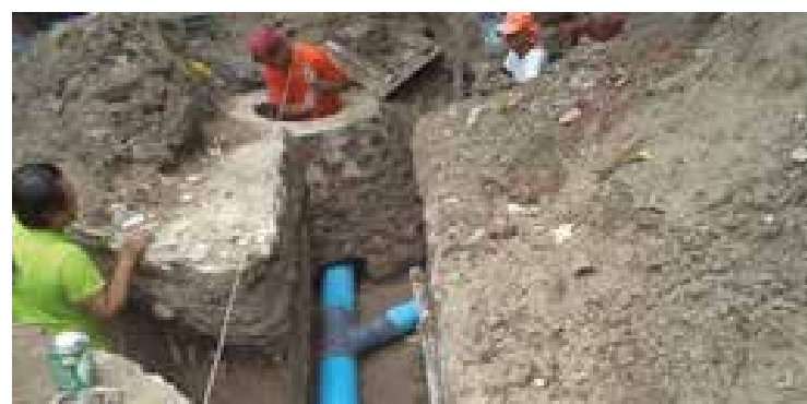
Instalación de tubería
