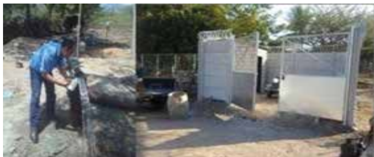
Pruebas de aforo y construcción y equipamiento de casetas.
