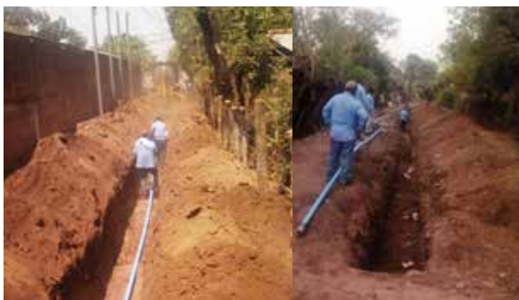
Instalación de tubería
