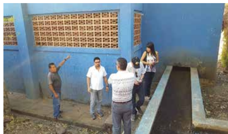
Planta Potabilizadora Chilama, departamento de La Libertad.
