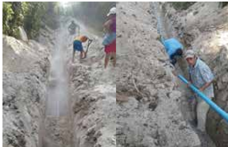
Excavación de zanjas e instalación de tuberías de agua potable
