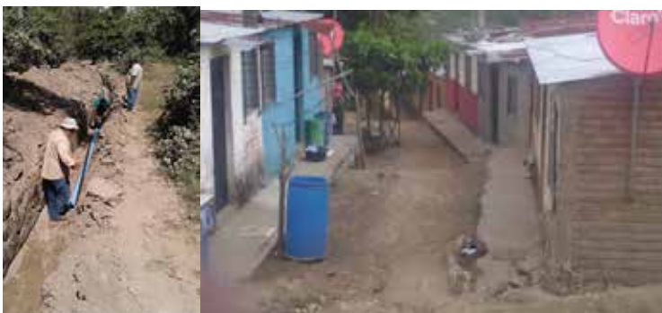
Excavación e introducción de tubería / Aterrado y compactado finalizado
