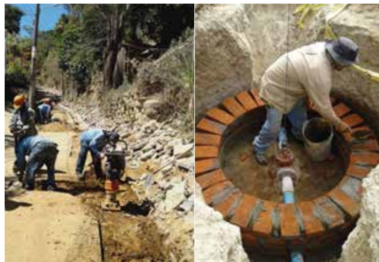
Excavación para instalación / Construcción de pozo de registro
