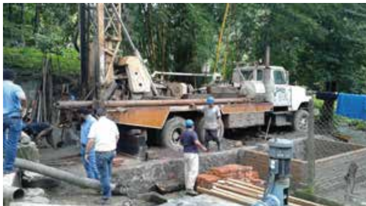
Perforación de pozo
