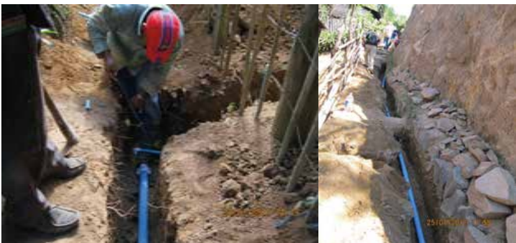
Instalación de red de agua potable
