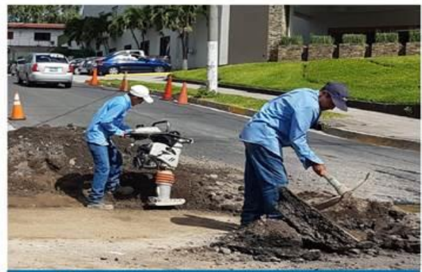
Brigada realiza labores de aterrado y asfaltado en bulevar Santa Elena de San Salvador
