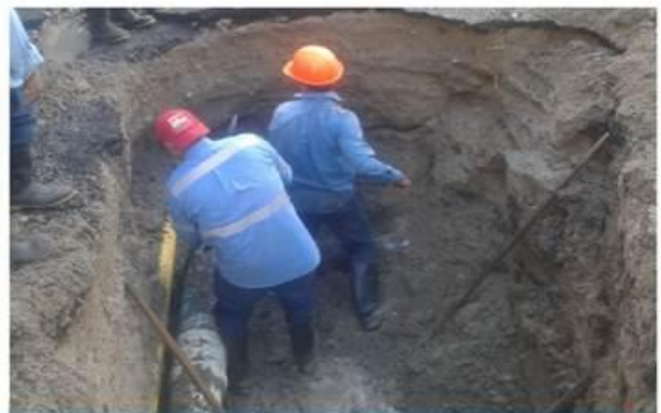
Cuadrilla sustituye tubería de agua potable que abastece a zonas del barrio San Jacinto
