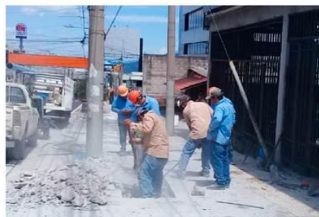
ANDA sustituye colector de aguas residuales en Paseo General Escalón
