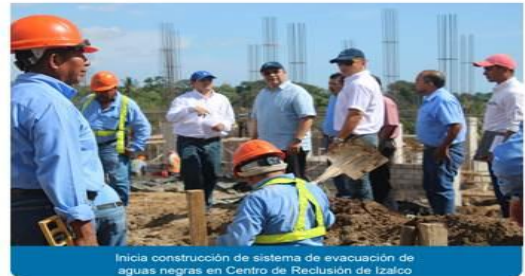
Inicia construcción de sistema de evacuación de aguas negras en Centro de Reclusión de Izalco
