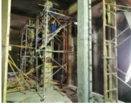
La estructura de soporte de la cisterna.
