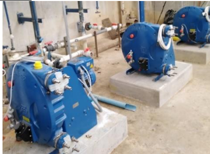
Montaje de bombas auxiliares, agitadores, dosificación de Sulfato de AL/PAC, carbón activo en planta química.
