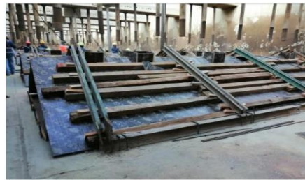
Intervención el Decantador C, realizando armadura, moldeado y colado de conos de concreto.
