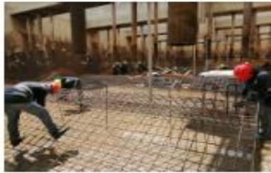
Intervención el Decantador C, realizando armadura, moldeado y colado de conos de concreto.
