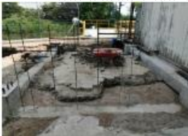
NUEVA SALA ELECTRICA. Colado de las fundaciones para la nueva sala eléctrica e Instalación de perfilera de acero
