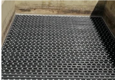
Montaje de boquillas filtrantes (Filtro 1 al 12)
