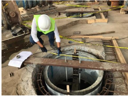
Construcción de bases para montaje bombas.
