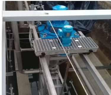
Montaje de Bombas de Extracción de Arenas
