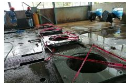
NUEVA SALA ELECTRICA. Colado de las fundaciones para la nueva sala eléctrica e Instalación de perfilera de acero
