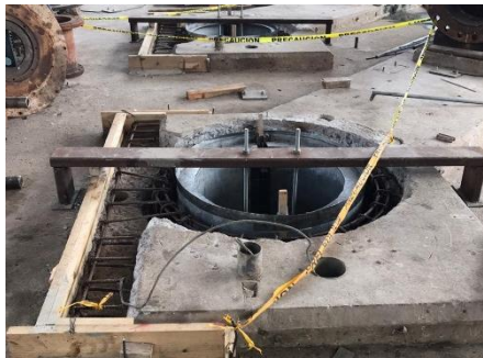
Construcción de bases para montaje bombas.
