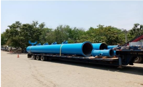
Instalación de tuberías de manifolds de 1200mm acero al carbón
