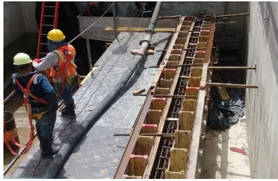
Recrecido de muretes e instalación del canal hidráulico de acero inoxidable
