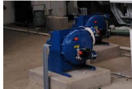
Montaje de bombas auxiliares, agitadores, dosificación de Sulfato de AL/PAC, carbón activo en planta química.
