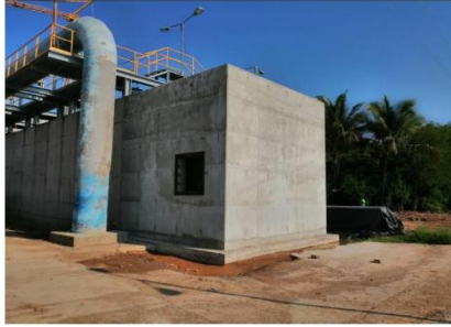
Ampliación de estructuras de concreto (Construcción del nuevo Tanque de Pretratamiento).
