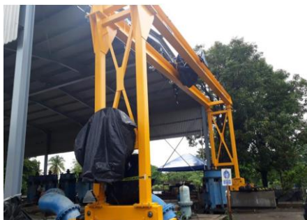
Montaje de Puente Grúa.
