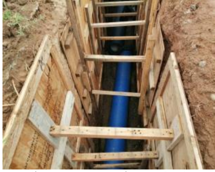
Colocación de adomado de la tubería de desagüe al río desde el reservorio.
