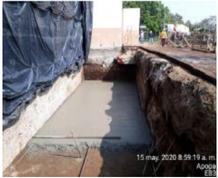
Colado de losa de fundación para NUEVAS SALA ELÉCTRICA.
