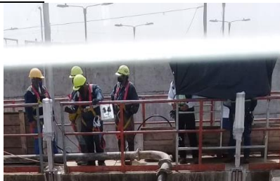
Instalación de Válvulas Neumáticas en filtros del 13 al 24
