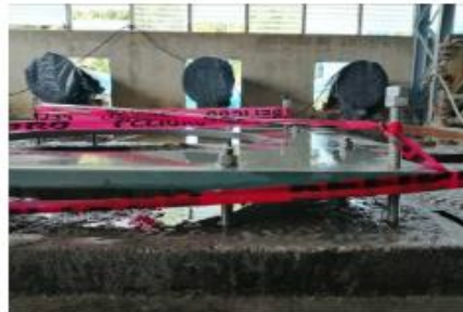
Construcción de bases para montaje bombas
