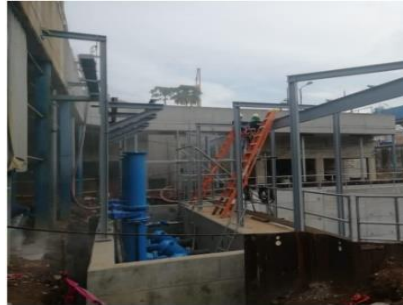
Montaje de equipos de bombeo de recuperación de agua de lavado.
