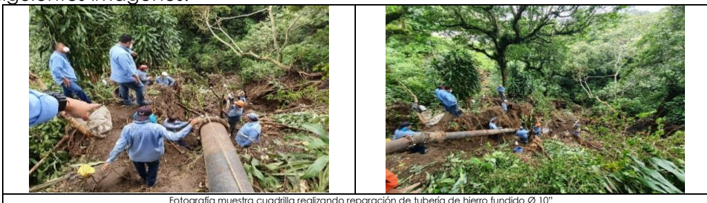
Fotografía muestra cuadrilla realizando reparación de tubería de hierro fundido \varnothing 10"
