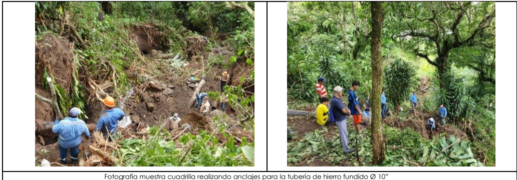
Fotografía muestra cuadrilla realizando anclajes para la tubería de hierro fundido Ø 10"
