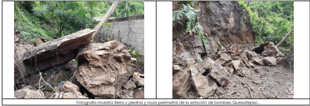
Fotografía muestra tierra y piedras y muro perimetral de la estación de bombeo Quezaltepec.
