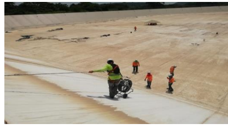
Colocación y soldadura de Geomembrana
