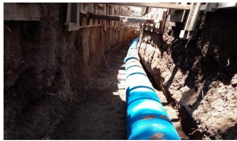
Colocación de tubería de drenaje.
