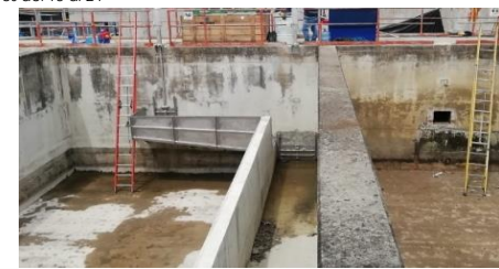
Recrido de muretes e instalación del canal hidráulico de acero inoxidable
