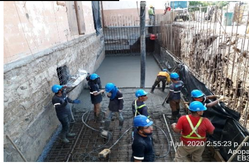
Colado de losa de fundación para NUEVAS SALA ELÉCTRICA.
