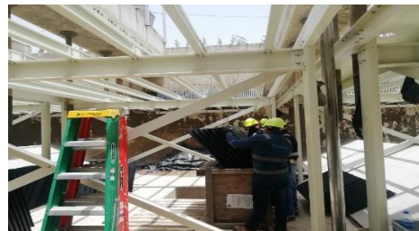
Intervención el Decantador C, realizando colado de conos de concreto y montaje de perfilera metálica y sistema lamelar.
