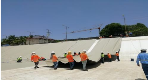
Colocación y soldadura de Geomembrana
