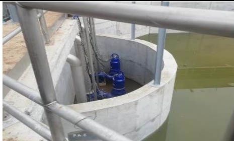
Montaje de equipos de bombeo de recuperación de agua de lavado.
