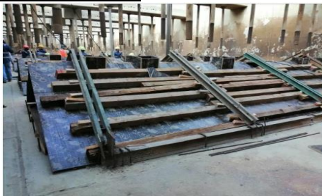
Intervención el Decantador C, realizando colado de conos de concreto y montaje de perfilera metálica y sistema lamelar.
