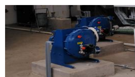
Montaje de bombas auxiliares, agitadores, dosificación de Sulfato de AL/PAC, carbón activo en planta química.
