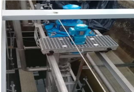
Montaje de Bombas de Extracción de Arenas
