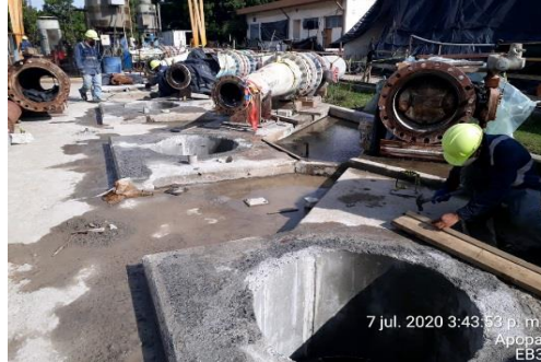
Construcción de bases para montaje bombas.
