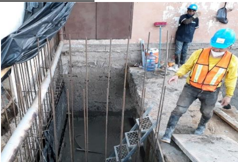
Ampliación de la Sala Eléctrica de EB1 (refuerzo, armadura, colado y curado).
