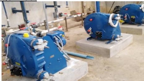
Montaje de bombas auxiliares, agitadores, dosificación de Sulfato de AL/PAC, carbón activo en planta química.
