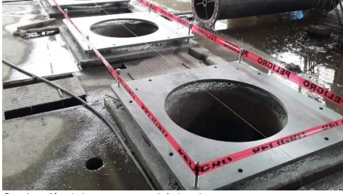
Construcción de bases para montaje bombas
