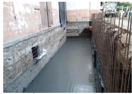
Colado de losa de fundación para NUEVAS SALA ELÉCTRICA.
