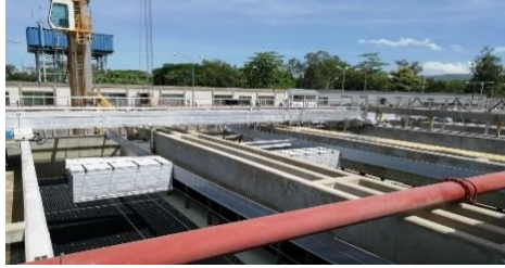
Montajes de Puentes de decantadores
