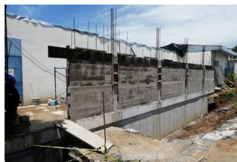
Ampliación de la Sala Eléctrica de EB1 (refuerzo, armadura, colado y curado).
