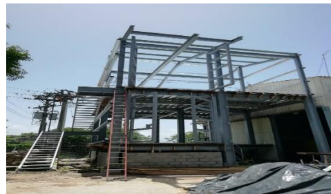
NUEVA SALA ELECTRICA. Instalación de perfilera de acero
