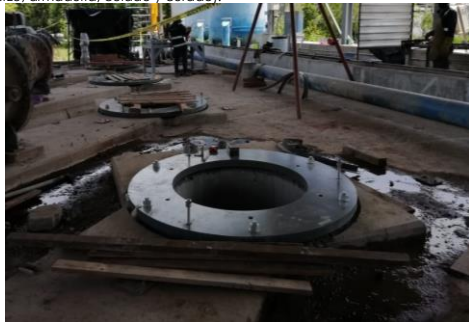
Construcción de bases para montaje bombas.
