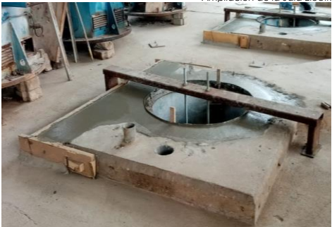
Construcción de bases para montaje bombas.
