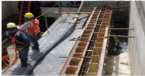
Recrido de muretes e instalación del canal hidráulico de acero inoxidable
