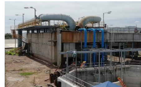
Montaje de equipos de bombeo de recuperación de agua de lavado.
