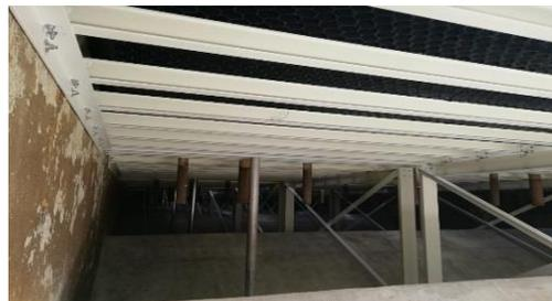
Intervención el Decantador C, realizando montaje de perfilera metálica y sistema lamelar.
