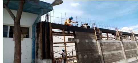
Se continúa con la ampliación de la Sala Eléctrica de EB1 (refuerzo, armadura, colado y curado).
