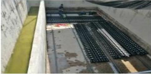
Montaje de boquillas filtrantes (Filtro 1 al 12)
