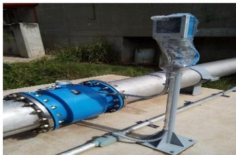
Medidor de Flujo electromagnético hacia Decantador
