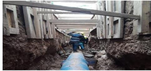
Ademado de la tubería de desagüe.
