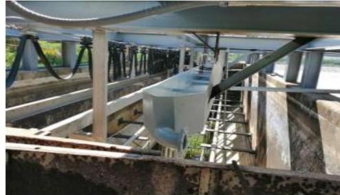
Se colocó el puente de arenas del desarenador.
