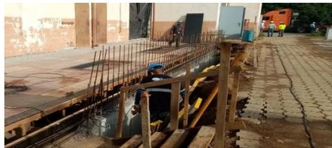
Se continúa con la construcción de NUEVA SALA ELÉCTRICA (refuerzo, armadura, colado y curado).
