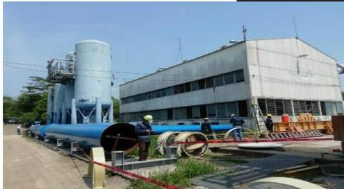
Instalación de tuberías de manifolds de 1200mm acero al carbón
