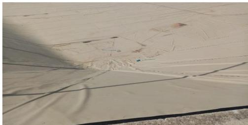
Continuación de colocación y soldadura de Geomembrana.
