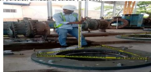
Se continúan trabajos de nivelación de placas de soporte para bombas.
