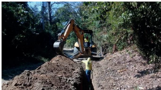
Zanjos para instalación de tubería de agua potable en Comunidad Las Cañas 1
