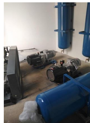
Montaje de compresores en EB2
