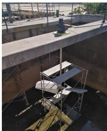
Montaje de Mezcladores
