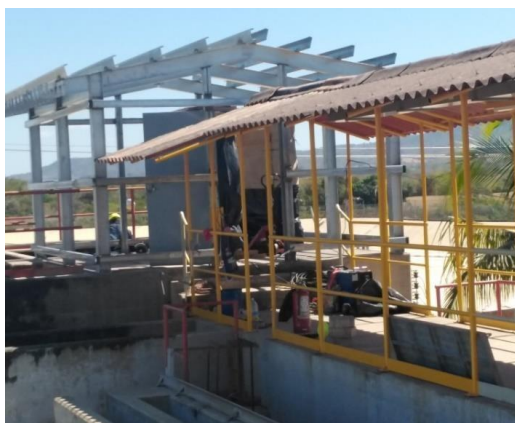
Construcción sala eléctrica decantadores
