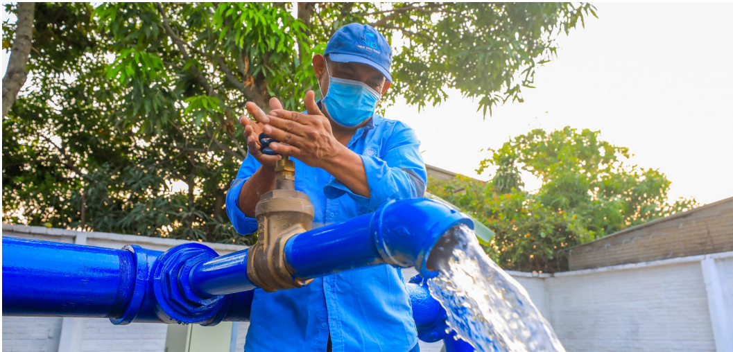
fotografía de archivo, servicio reconectado, Fotografía: Willian Carranza
