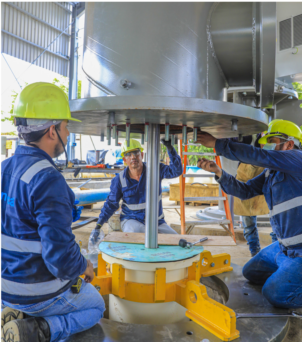
Montaje de motor en las Pavas 5 de Mayo 2021, Proyecto en ejecución, San Pablo Tacachico Fotografía: Willian Carranza
