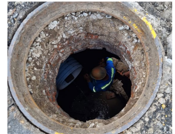
Mantenimiento en redes y acometidas de acueducto Fotografías de archivo
