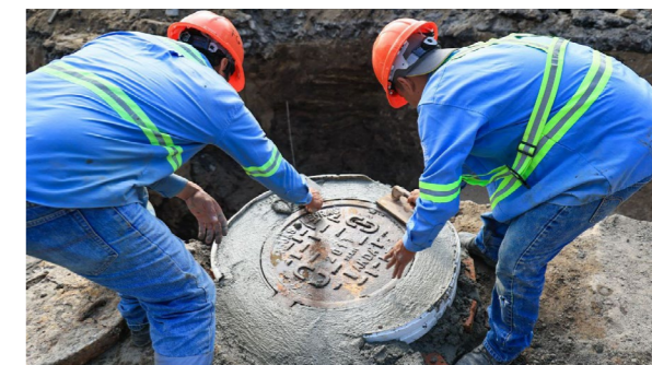
Trabajos de nuevas conexiones y alcantarillado
