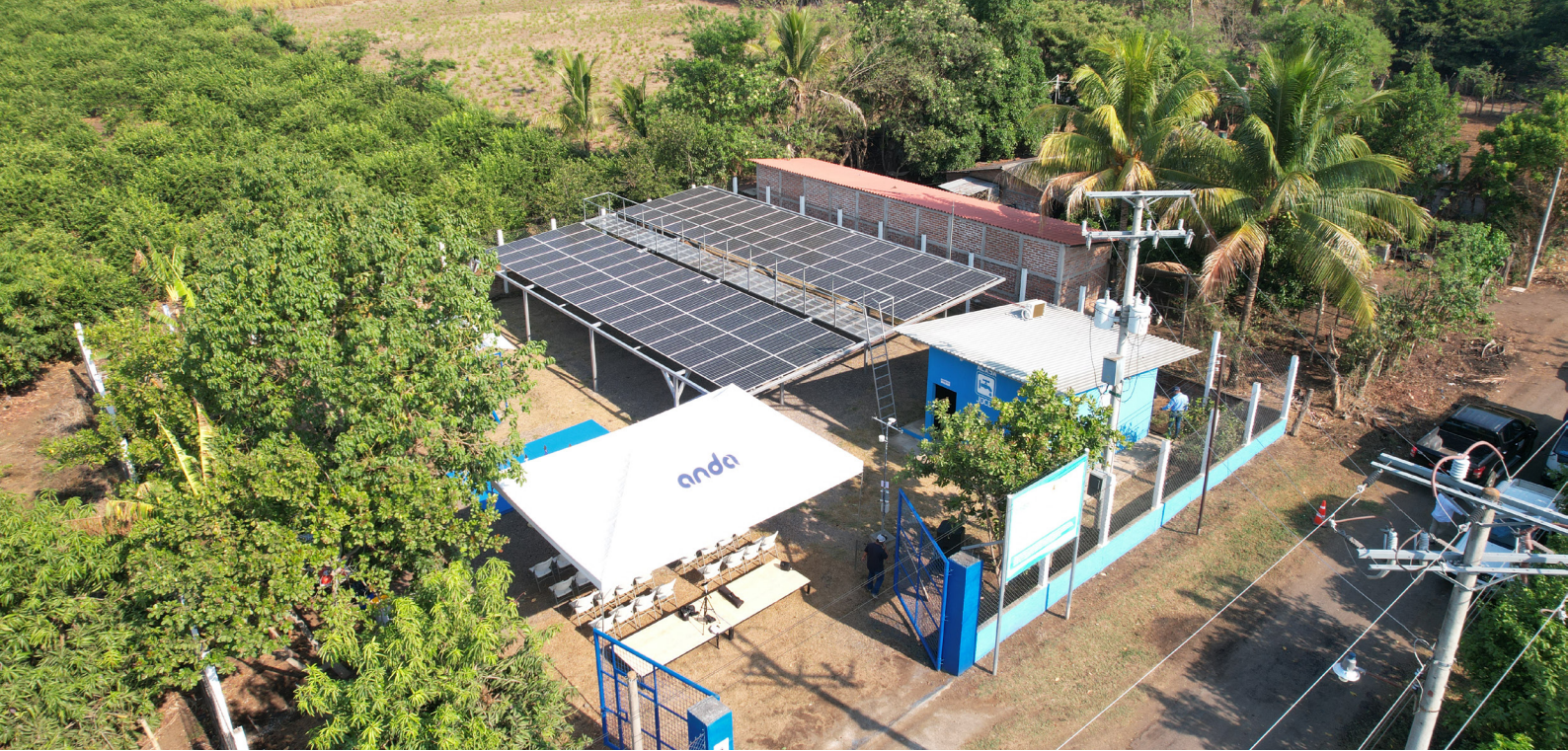
Instalación de paneles solares en sistema de ACASAJECE, municipio El Rosario La Paz
