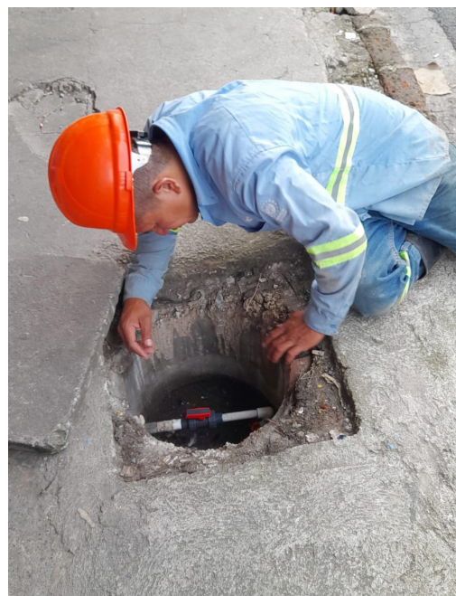
Personal de ANDA en Instalación de medidores
