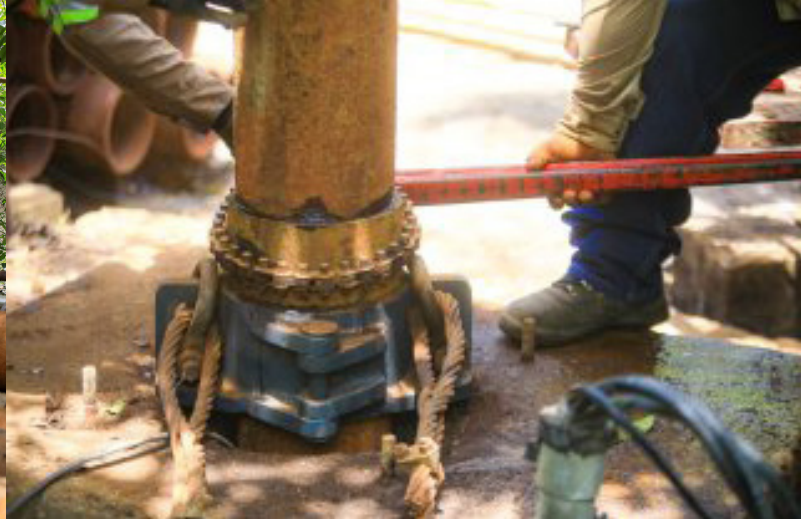
Trabajos en ejecución de perforación de pozos. Foto de Archivo
