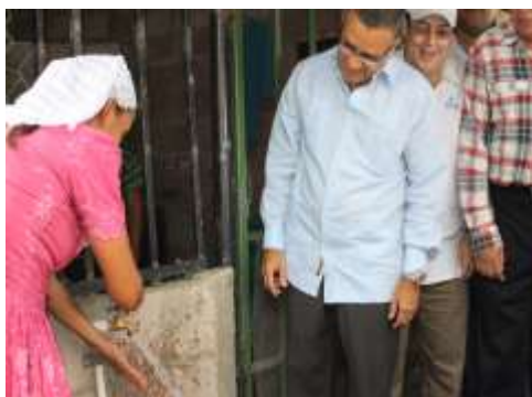
COLOCACIÓN DE ESTRUCTURA Y TUBERÍA EN NEJAPA
