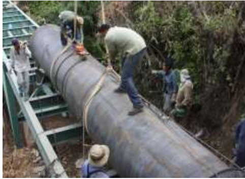
COLOCACIÓN DE ESTRUCTURA Y TUBERÍA EN NEJAPA
