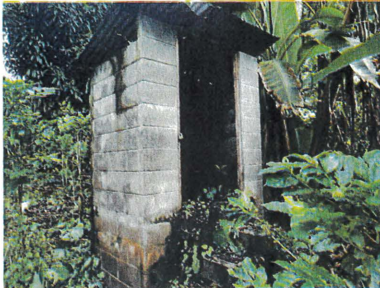
Figura 1. Fosa séptica en aparente desuso en la zona cercana del sitio de exploración.
