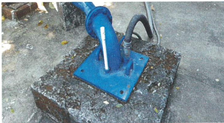
Tubería de salida de pozo #1, de la Desarrolladora Madreselva S.A de C.V.
