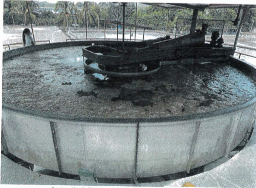
Ilustración 4. Sistema de Flotación por Aire Disuelto (DAF)
