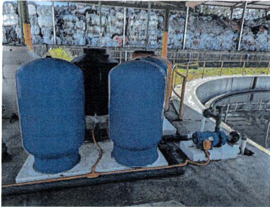
Figura 6. Proceso de desinfección con Hipoclorito de Calcio.
