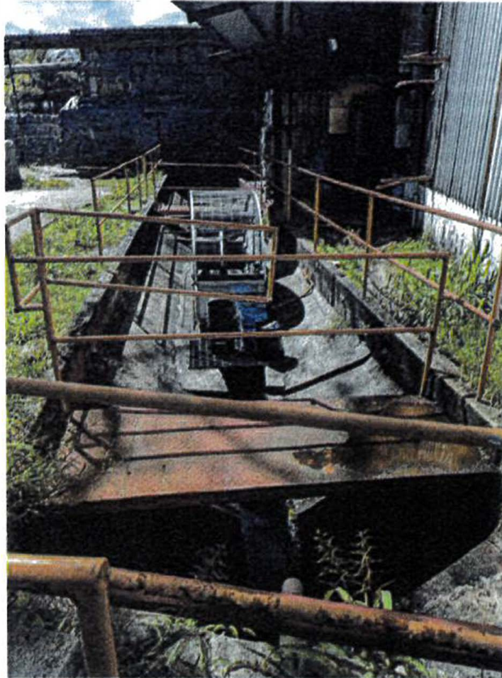
Figura 2. Tamizada de aguas residuales provenientes de áreas de tintorería, estampación y caldera.
