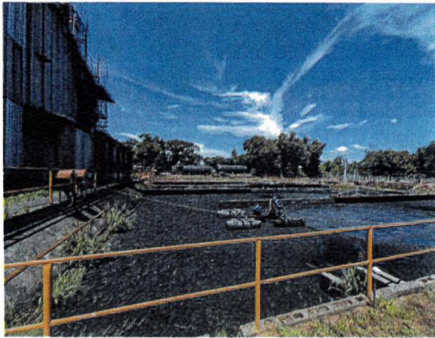
Figura 4. Tratamiento biológico, Lodos activados (Sistema aeróbico).
