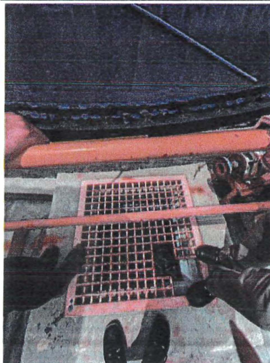
Figura 5. Proceso de desinfección de aguas residuales, dosificación con cloro.
