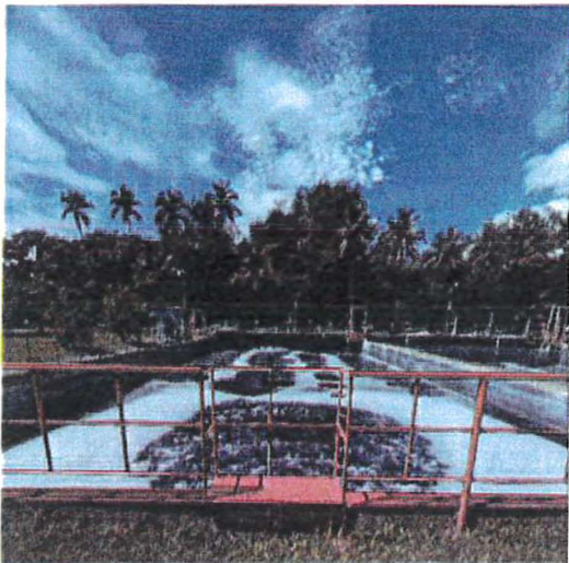
Figura 2. Tratamiento de aguas residuales con color en tanque de estabilización y clarificador de color.
