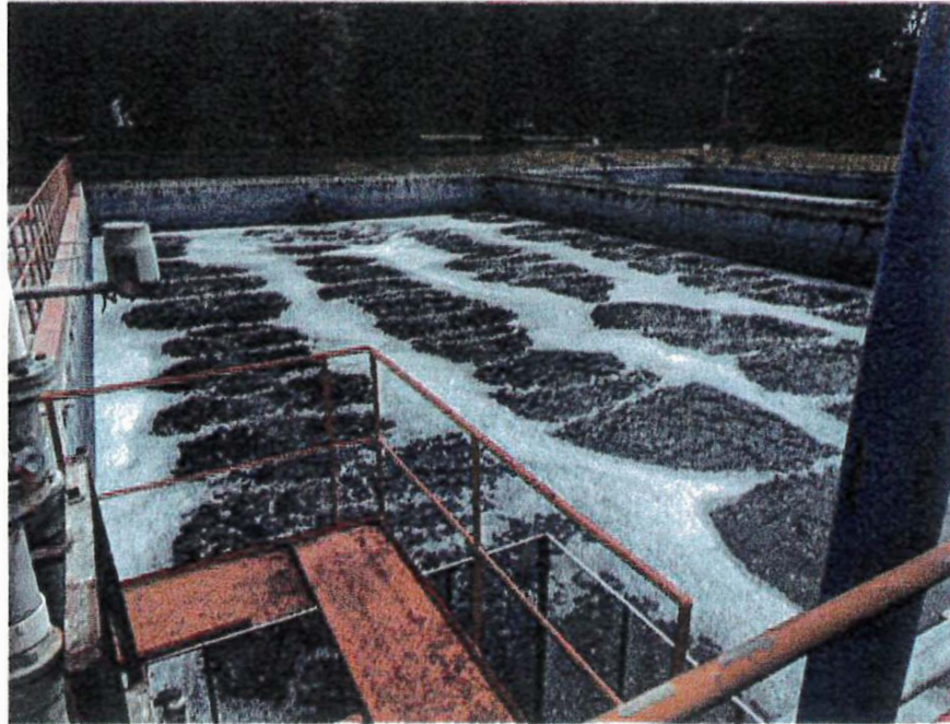
Figura 3. Mezcla de aguas residuales con color tratadas y aguas sin color en segundo tanque de estabilización.
