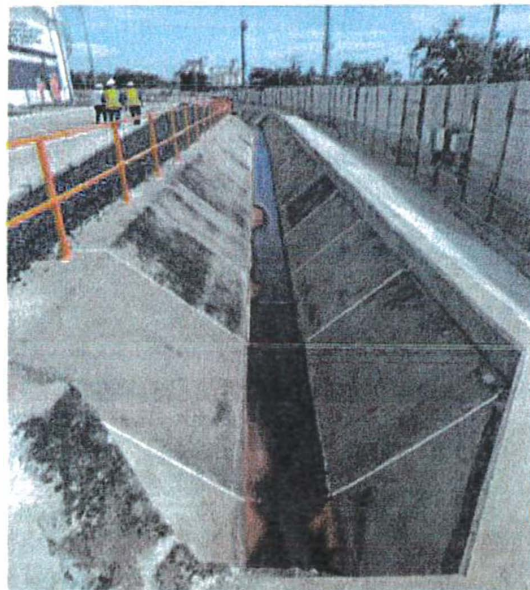
Imagen 2. Canaleta de aguas lluvias dentro del inmueble de la sociedad
