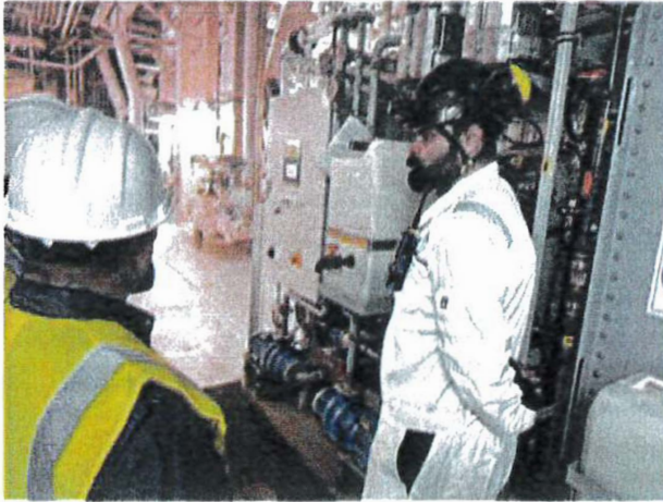
Ilustración 1. Inspección de la PTAR en el barco BW Tatiana
