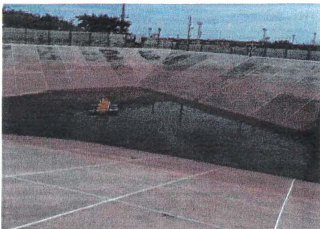
Imagen 3. Estanque de retención de aguas lluvias
