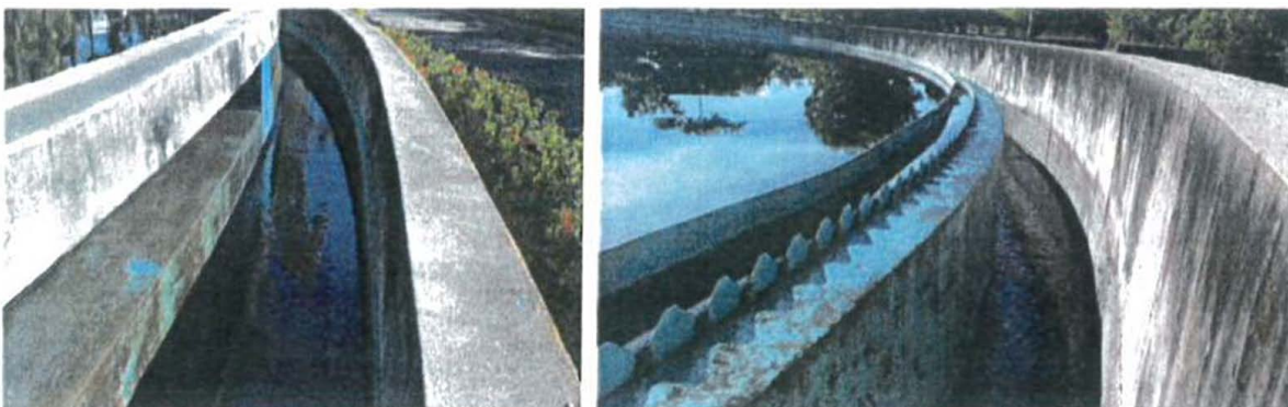
Figura 2. Clarificadores, separación de sólidos en suspensión de las aguas residuales tratadas.
