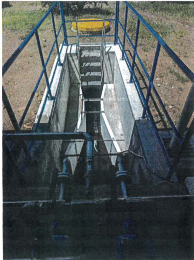
Figura 4. Canaleta Parshall, descarga de aguas residuales tratadas hacia media receptor.
