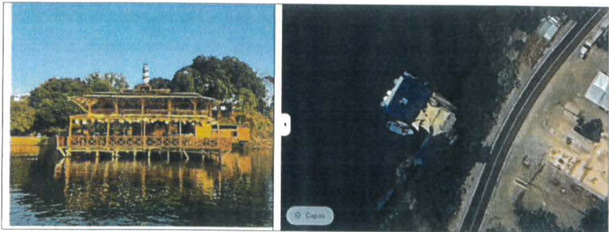
Figura 1. Ubicación del Restaurante Faro Clareño sobre el Dominio Público Hidráulico.
