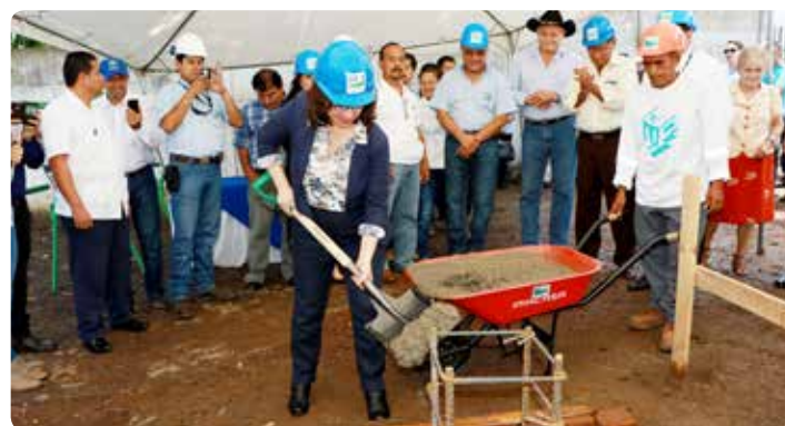
En septiembre de 2016 se inició la construcción del edificio propio para la agencia de San Francisco Gotera. La inauguración está prevista para abril de 2017.
