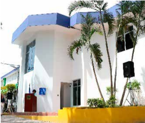
Nuevo Edificio Administración Superior
