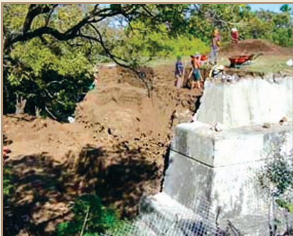
Fachada sur de la estructura B1-2/marzo 2005.
