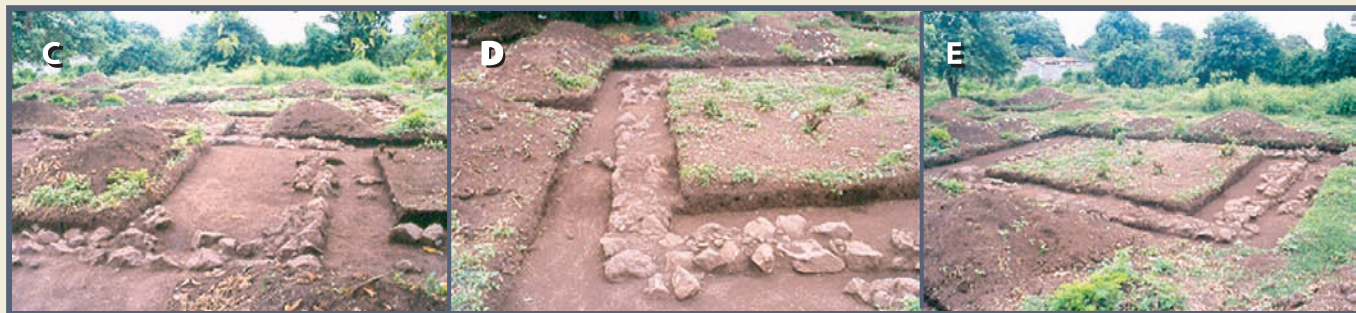
Foto C- conjunto arquitectónico 1-b, parte sur, vista desde el lado oeste. Foto D- Conjunto arquitectónico 1-a, esquina suroeste, vista desde el este. Foto E- conjunto arquitectónico q-a, visto desde el lado oeste. La distribución de cimientos mostrados en los conjuntos arquitectónicos en las fotografías C, D y E nos permiten creer que se trata de unidades habitacionales. Fotografía: Shione Shibata por el Departamento de Arqueología.
