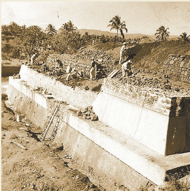
Fachada sur de la estructura B1-2 durante los trabajos de restauración en marzo 1950
