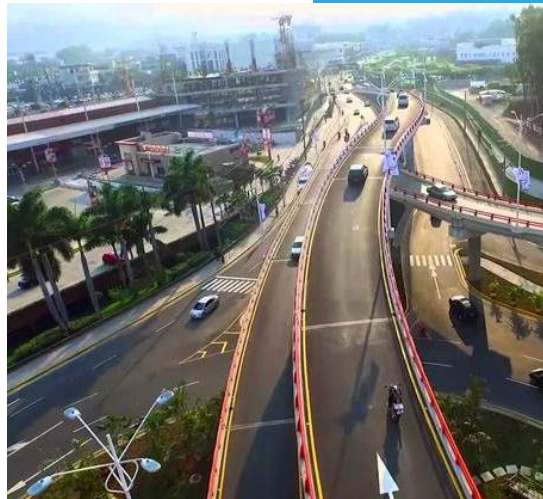
Construcción y mejora de 771.14 kilómetros de carretera
