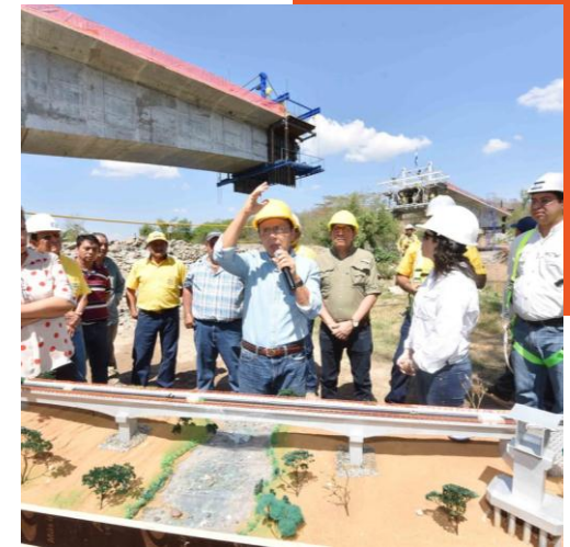
Construcción del Puente San Isidro, San Pablo Tacachico-Nueva Concepción
