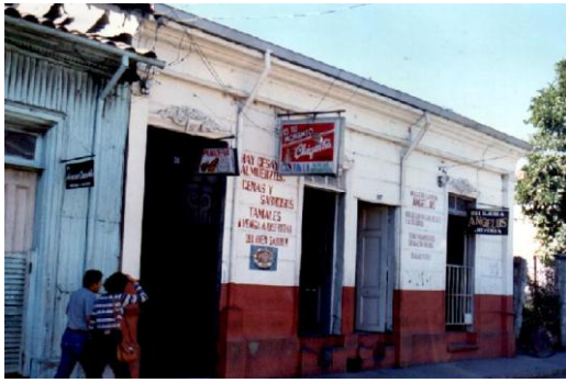
Inmueble: 3 Nombre del Inmueble: Comercios Varios Dirección: 6ª Avenida Sur y 6ª Calle Oriente No 334 Categoría Propuesta: Monumento Subcategoría Propuesta: Monumento Ambiental
