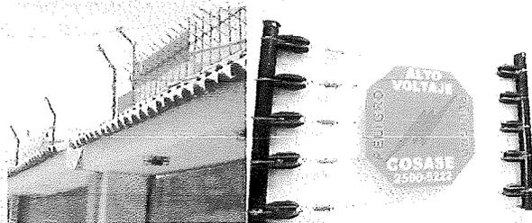
Alarma audible al cortar cualquier alambre del sistema
