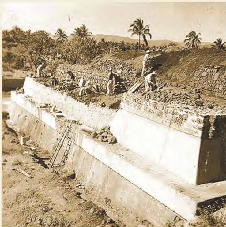
Fachada sur de la estructura B1-2 durante los trabajos de restauración en marzo 1950
