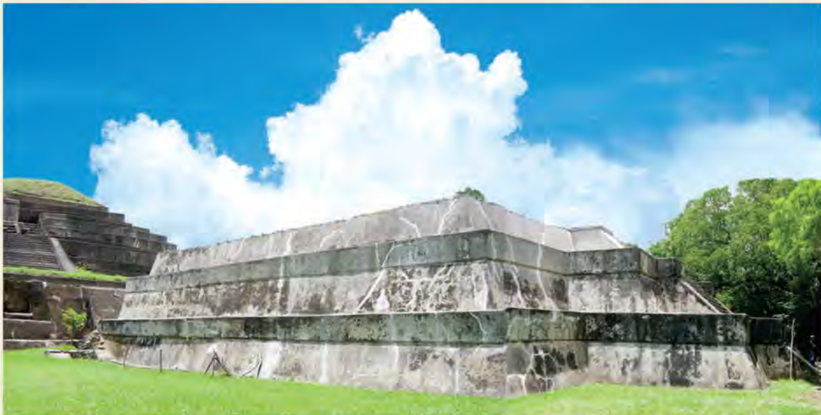
Fachada norte del basamento. Vista general de la restauración con cemento. El área afectada fue similar a la expuesta en la fotografía. Fotografía: Shinya Kato
