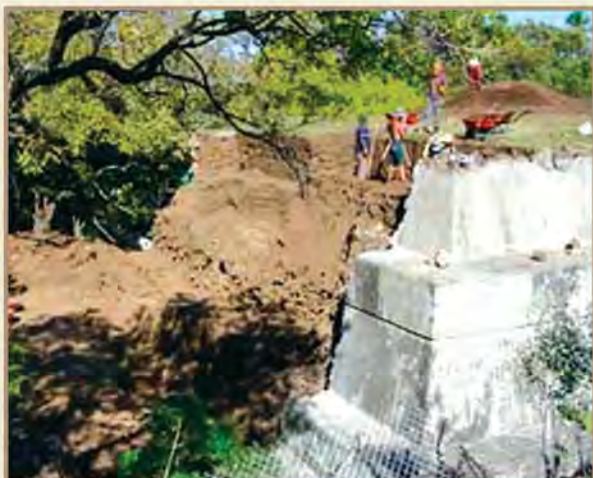
Fachada sur de la estructura B1-2/marzo 2005.
