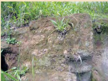
Figura 9 La parte superior de la pared suroeste de la Estructura 5
