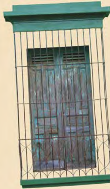
Portón de acceso principal con pilastras adosadas, Chalchuapa
