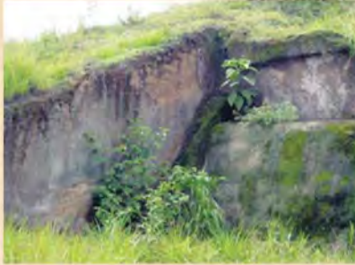
Figura 10 La pared de la escalinata del basamento superior de la Estructura 5
