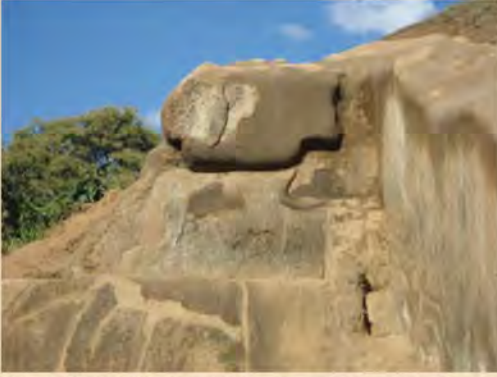
Figura 104 Después de la restauración en el sector suroeste del basamento superior
