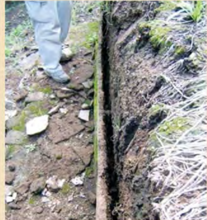
Figura 13 El espacio vacío entre el repello y los adobes en la pared norte del basamento superior de la Estructura 5
