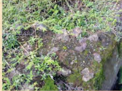
Figura 11 La parte superior de la pared sureste de la Estructura 5
