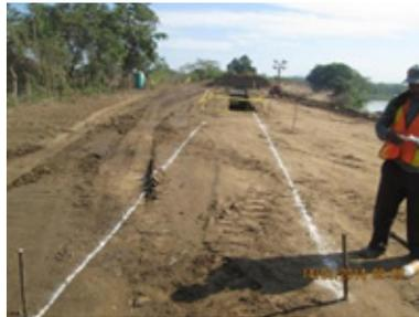
Excavación para diente de apoyo de nueva borda
