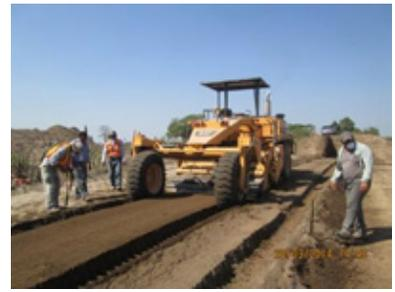
Colocación de bolsas de cemento ASTM C 1157 HE, sobre capa suelta de suelo.
