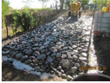
Proceso de colocación de piedra sobre cama de mortero
