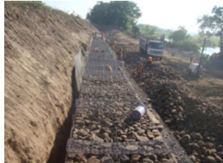
Proceso: Colocación de piedra (Piedraplén) sobre lodocreto, en excavación para base de muro gavión
