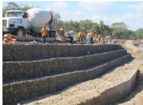
Muro gavión construido. Proceso de colocación de lodocreto en cuña superior de muro gavión
