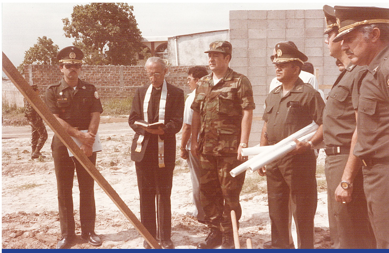
Acto de bendición del área de construcción del edificio del CEFAFA.
